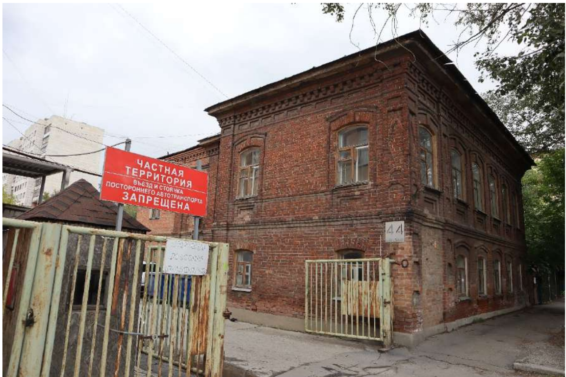
Фото 4. Точка визуального восприятия объекта в северо-восточном направлении на расстоянии 10 м от ОКН (комфортный вид восприятия объекта)
