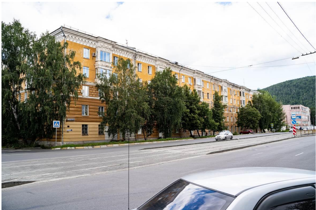
«Дом жилой, архитектор П.А.Сибрин». Вид с юго-запада. Фото 21.09.2022 г.
