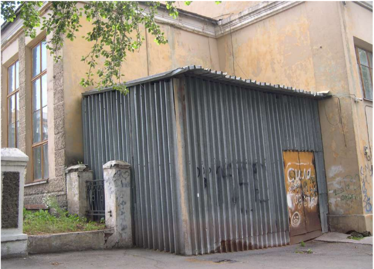
Рис.32 Вид на металлический пристрой со стороны северо-западного угла здания.
