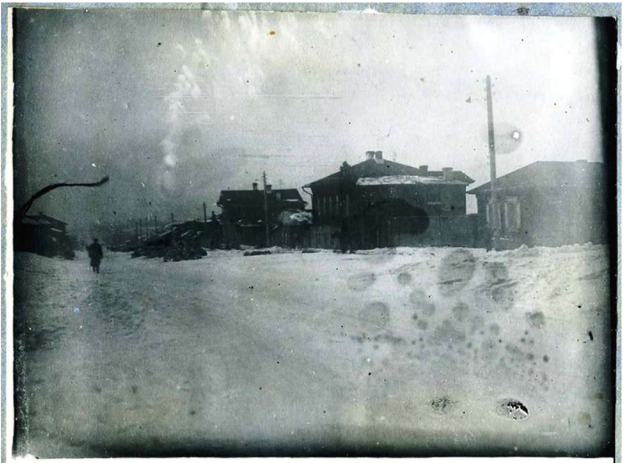
Рис. 16 Улица Всеобуча (вид со стороны ул.Спартака). Поселок ЧГРЭС, 1936 год. Ссылка: http://img-fotki.yandex.ru/get/7/5661614.41/0_7d356_15e0b71b_XL.jpg
