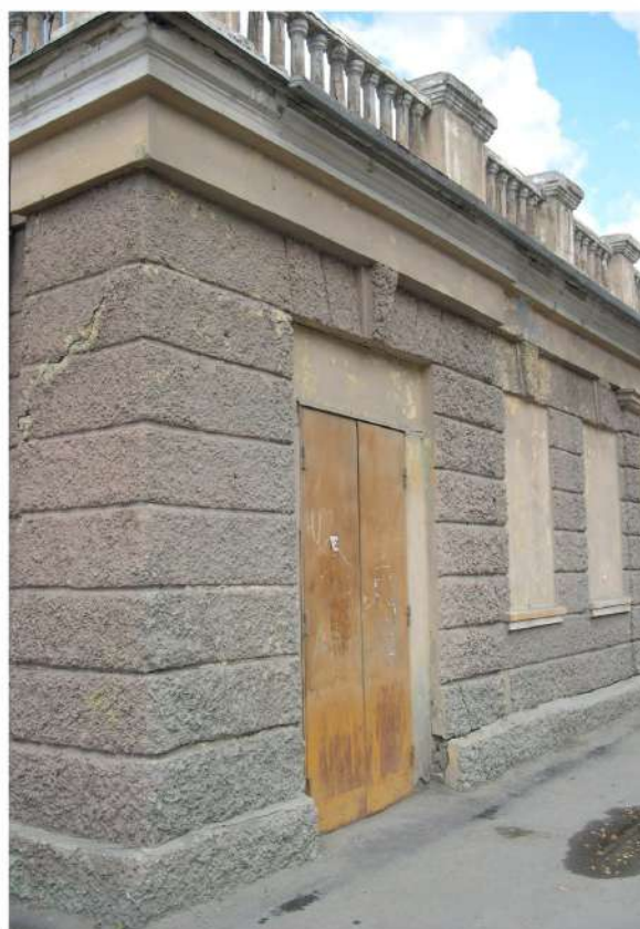
Рис.21 Южная часть со входом пристроя со стороны восточного фасада.
