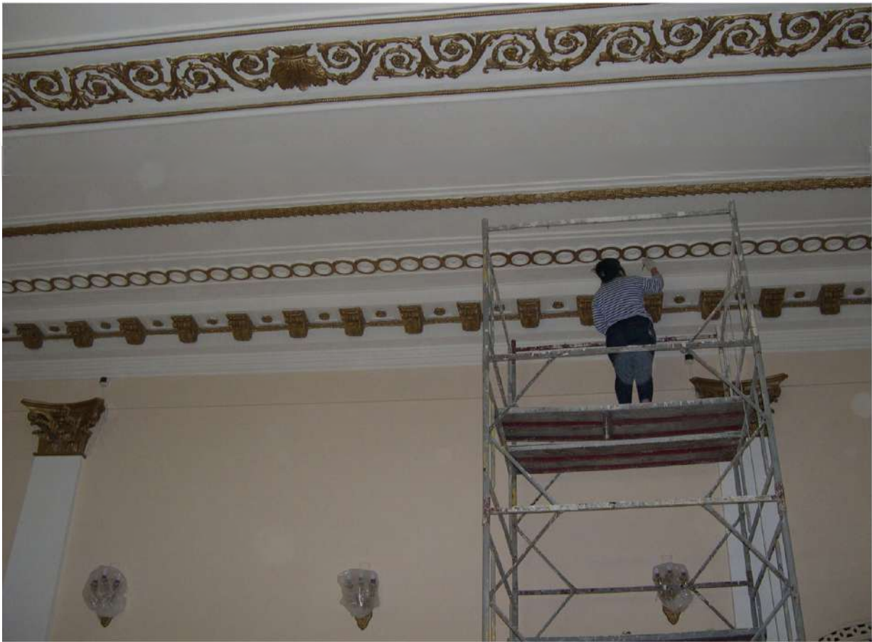
Рис.40 Стена и потолок с лепным декором зрительного зала.
