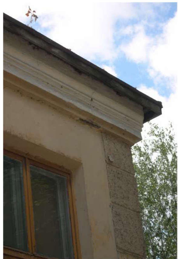
Рис.11 Вид на карниз западной части главного фасада
