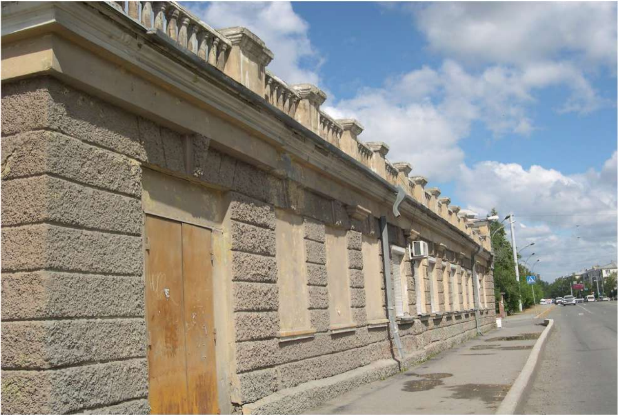
Рис.12 Вид на пристрой со стороны восточного фасада.
