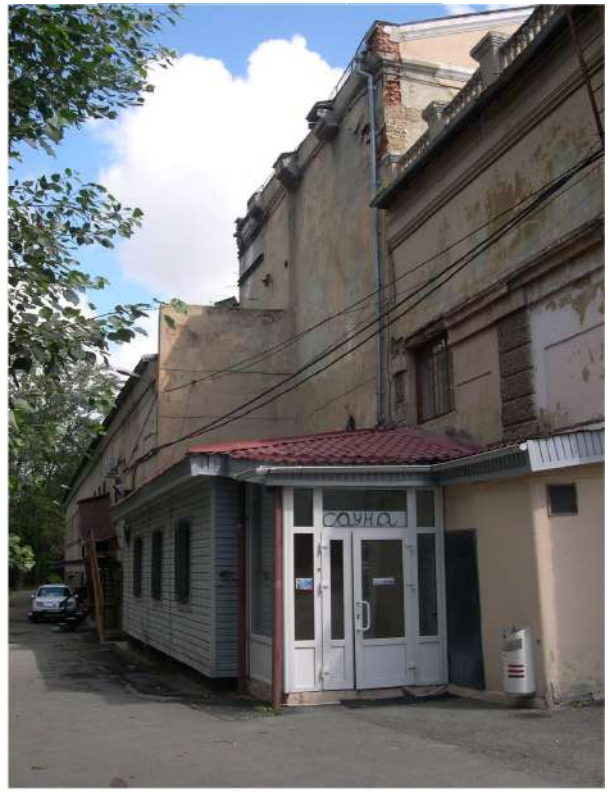
Рис.30 Вид на пристрой южной части западного фасада с юга.
