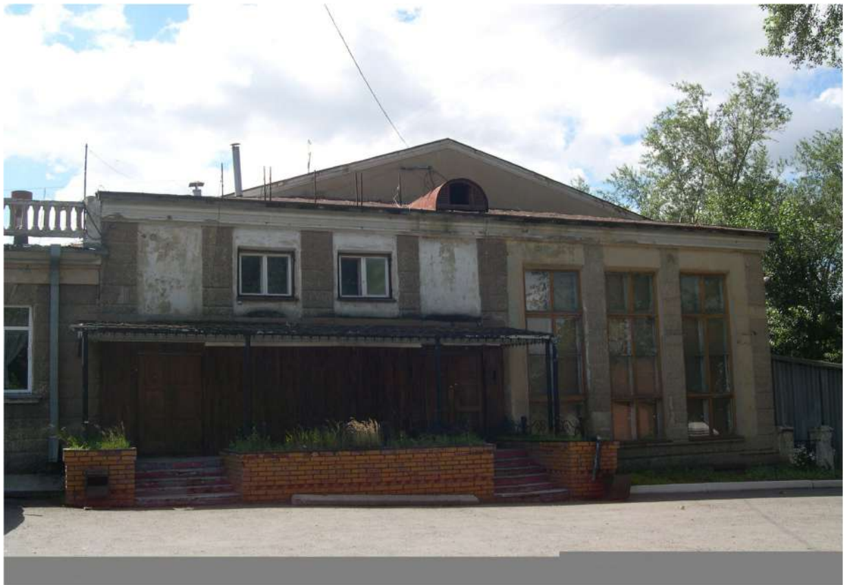
Рис.6 Вид на центральную часть главного фасада «Клуба ЧЭМК».
