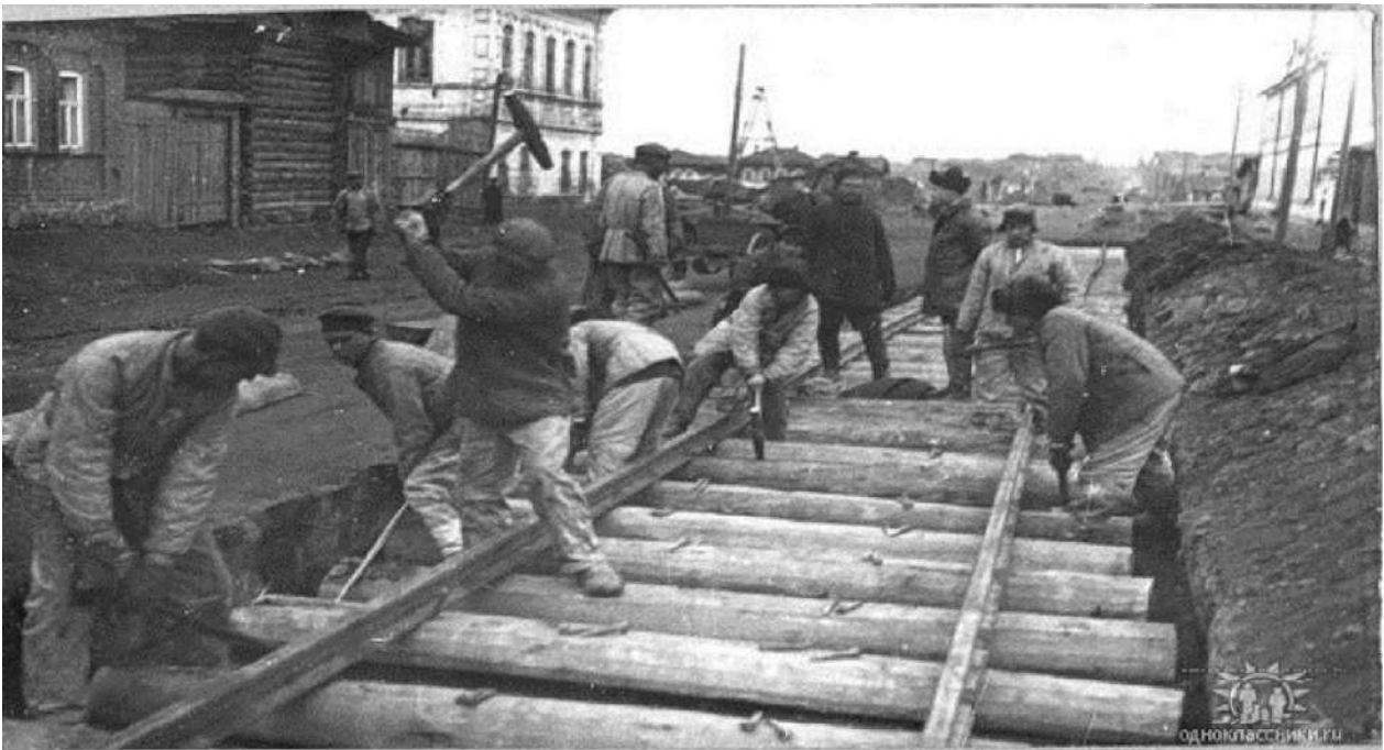
Рис. 15 Строительство трамвайный путей. Площадь Павших революционеров. Поселок ЧГРЭС, 1931 год. Ссылка: http://img-fotki.yandex.ru/get/4113/yuvl.17/0_3ea34_69e388ac_XL.jpg
