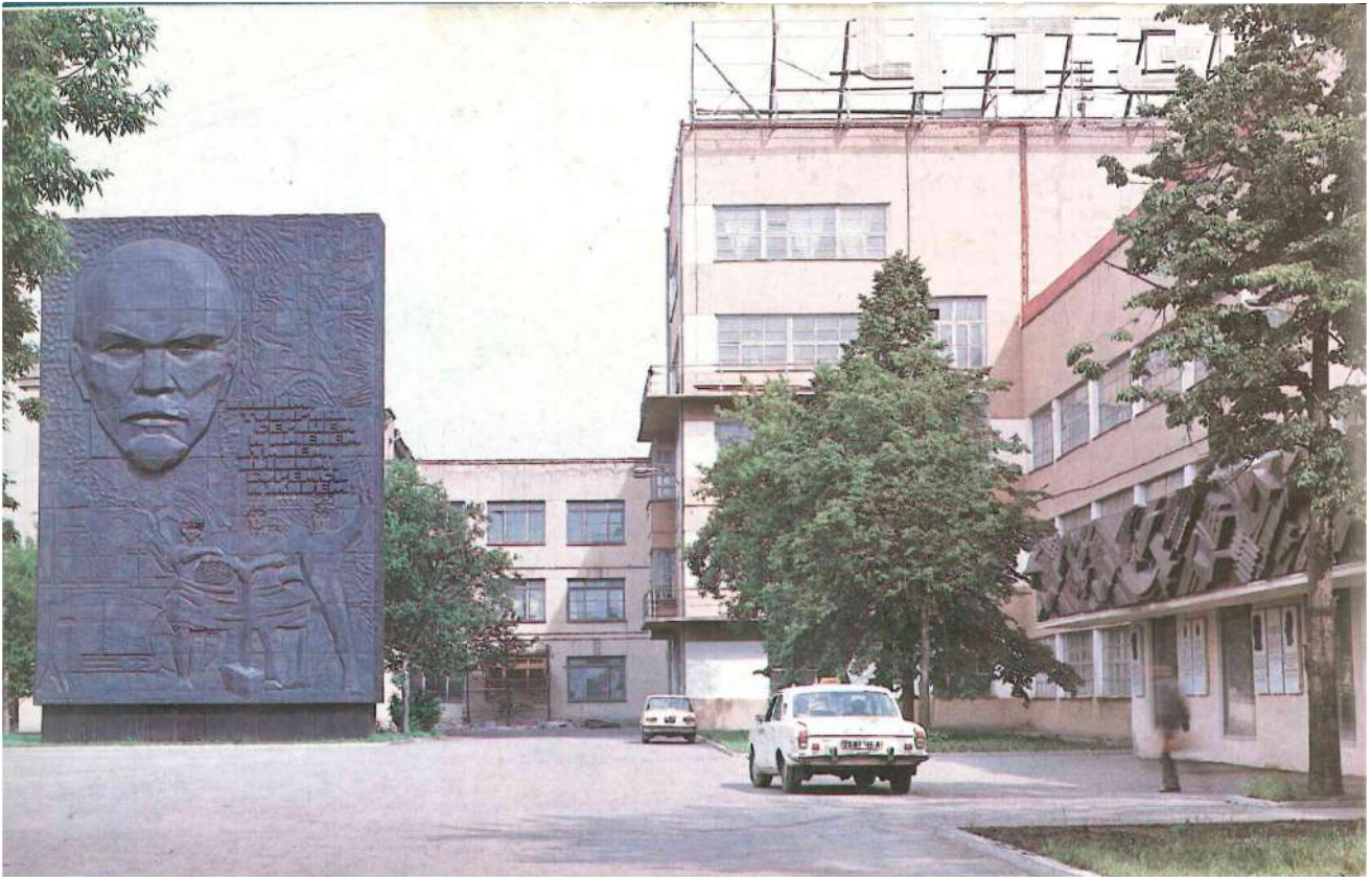
Рис. 50 Здание заводоуправления Челябинского тракторного завода. Построено в 1930-1933гг. Архитектор А.Буров (Фото конца 20в)
