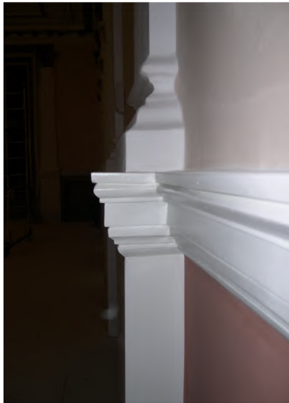
Рис.45 Нижняя часть стены с пилястрой зрительного зала
