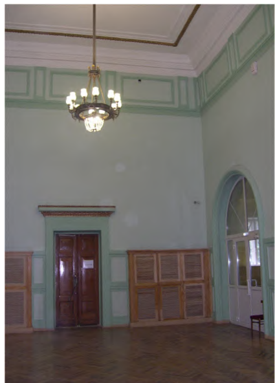
Рис.51 Западная и северная стены фойе зрительного зала.
