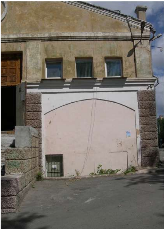
Рис.25 Восточная часть южного фасада.
