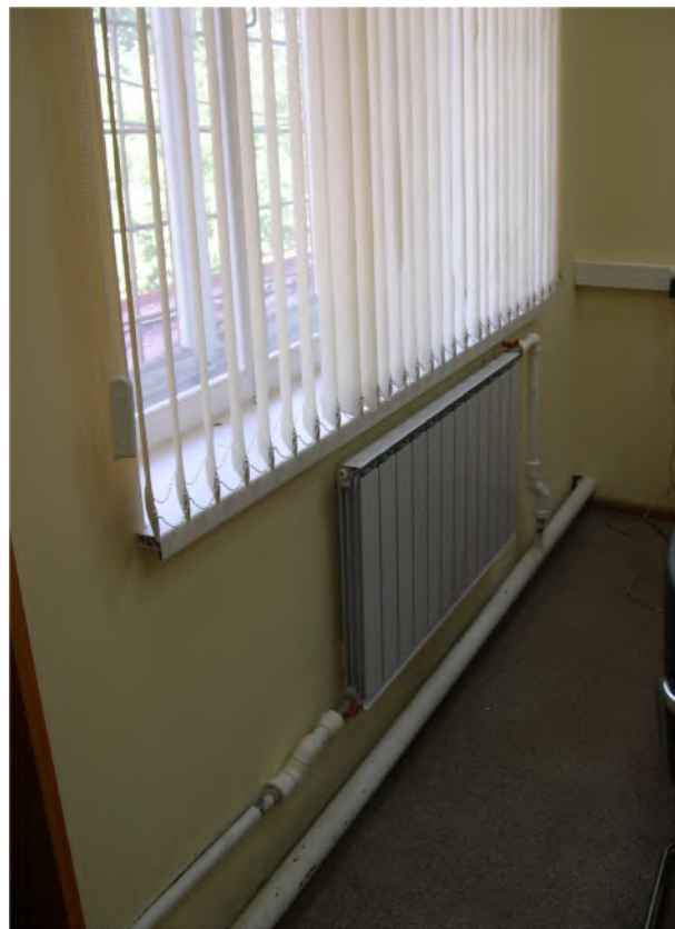
Рис.69 Установка отопительного прибора и открытая прокладка компьютерной сети.
