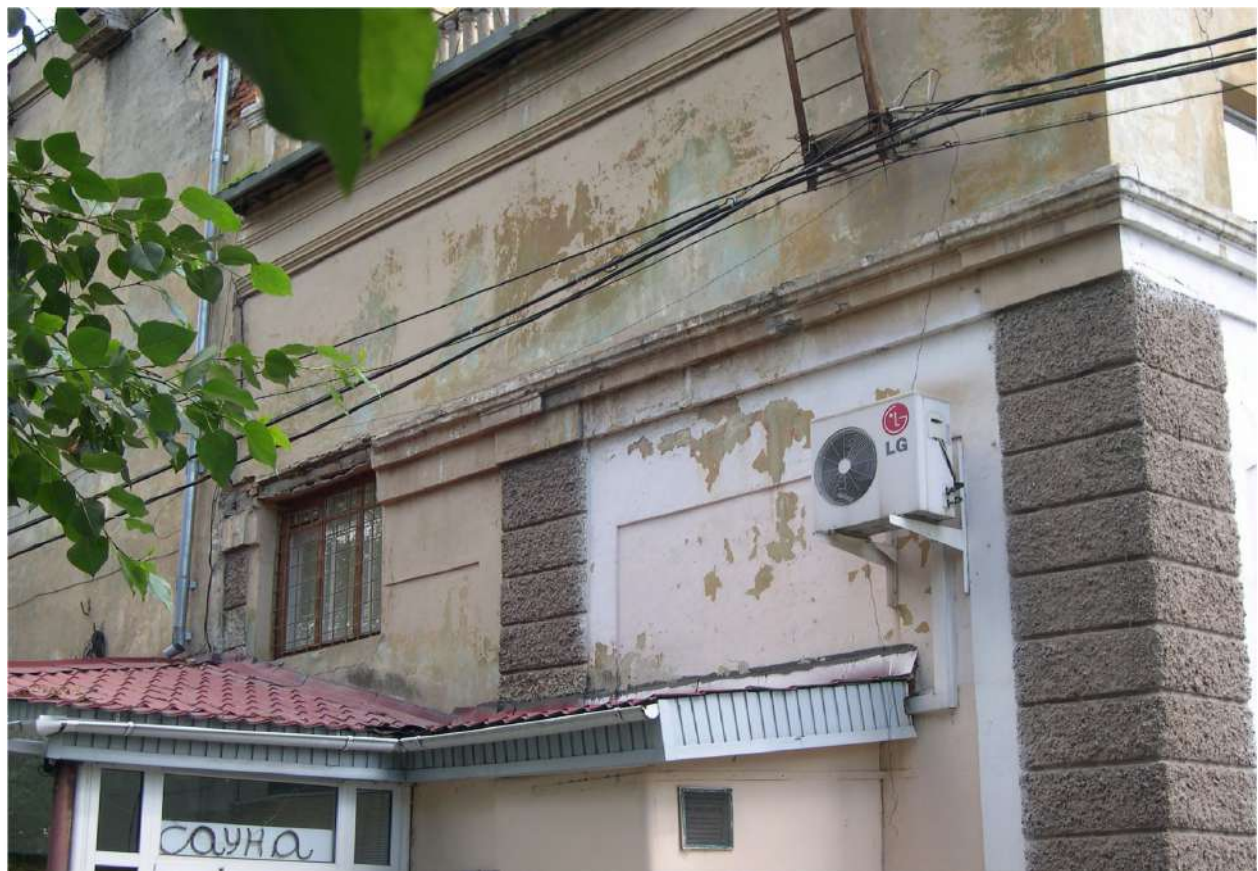
Рис.35 Вид на южную часть западного фасада.
