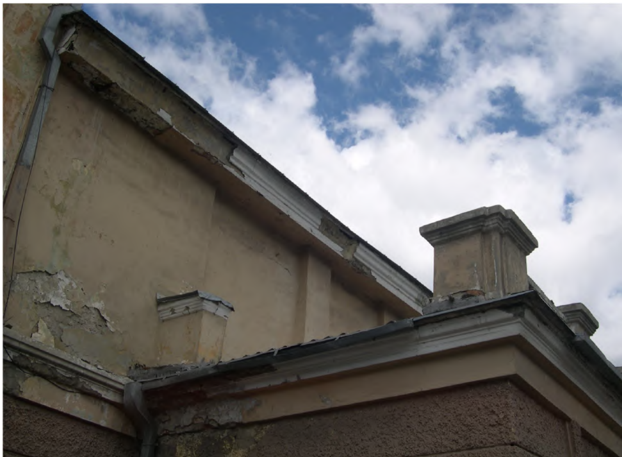
Рис.22 Верхняя часть южного фасада пристроя со стороны ул. Российской.
