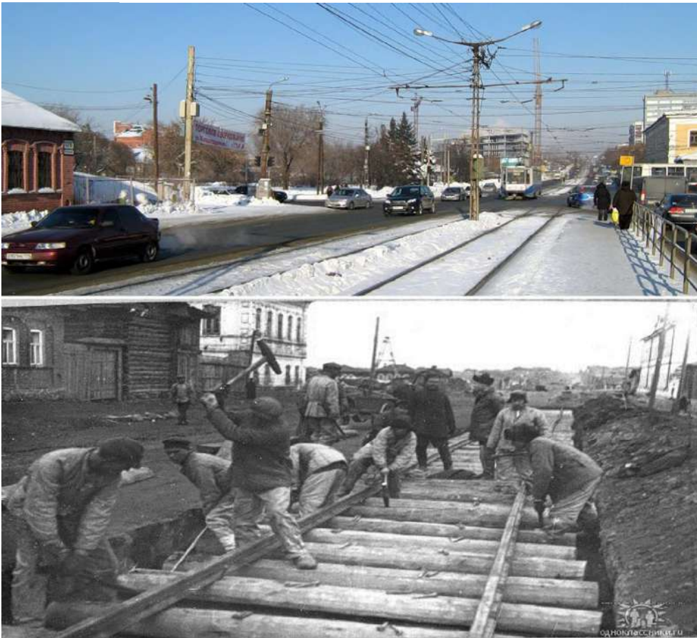
Рис.24 Ул. Российская, строительство трамвайных путей; фото 1931 г./ 2013 г. Ссылка: http://img-fotki.yandex.ru/get/4113/yuvl.17/0_3ea34_69e388ac_XL.jpg.jpg
