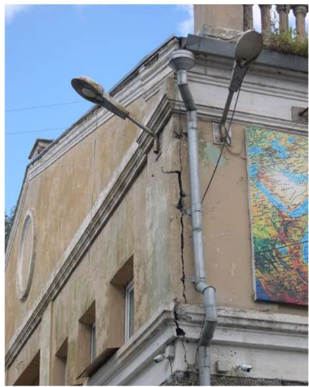
Рис.26 Вид на верхнюю часть южного фасада.
