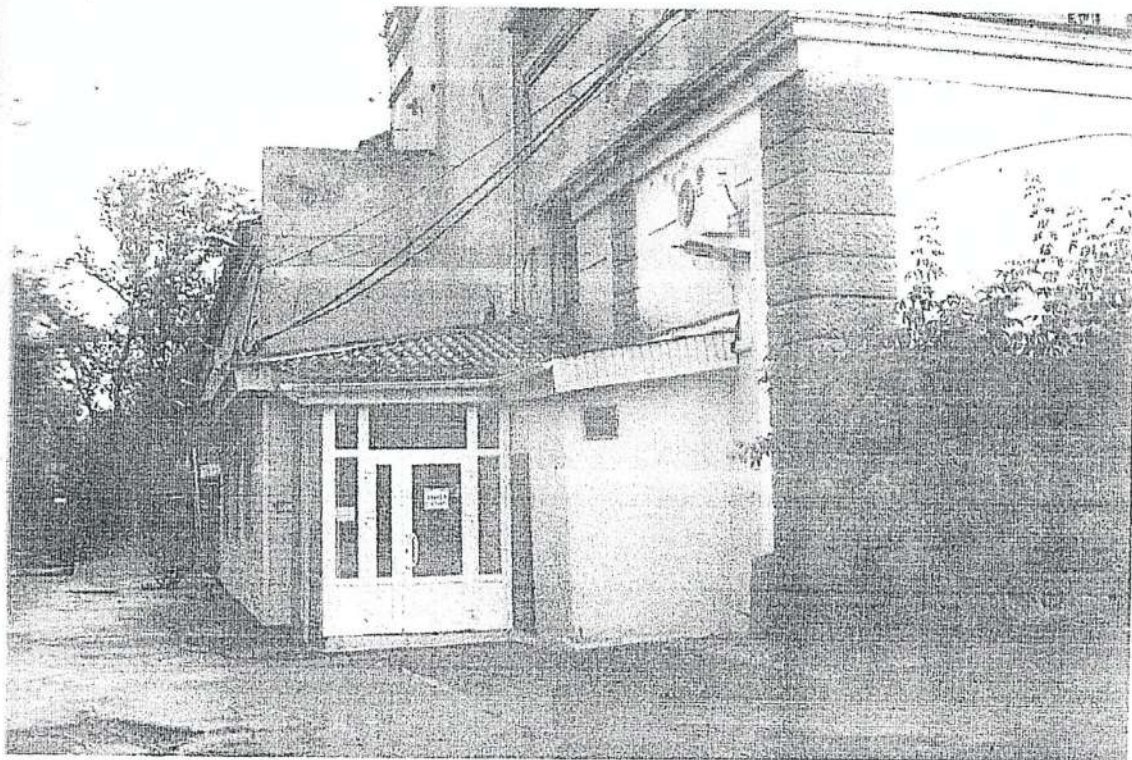
Фото 7. Вид на здание с юго-западной стороны
