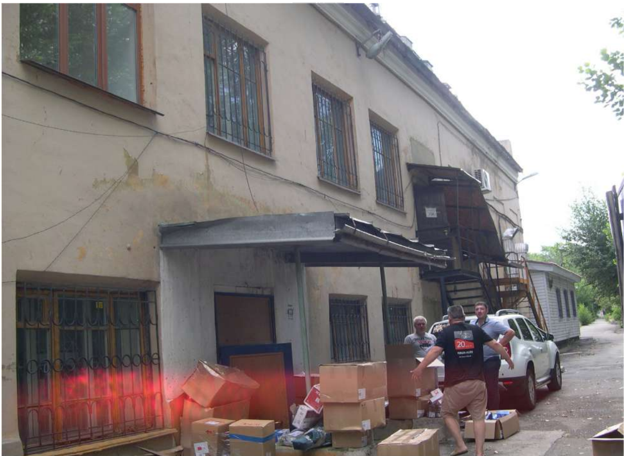
Рис.31 Вид на служебный и дополнительный входы с южной стороны западного фасада.
