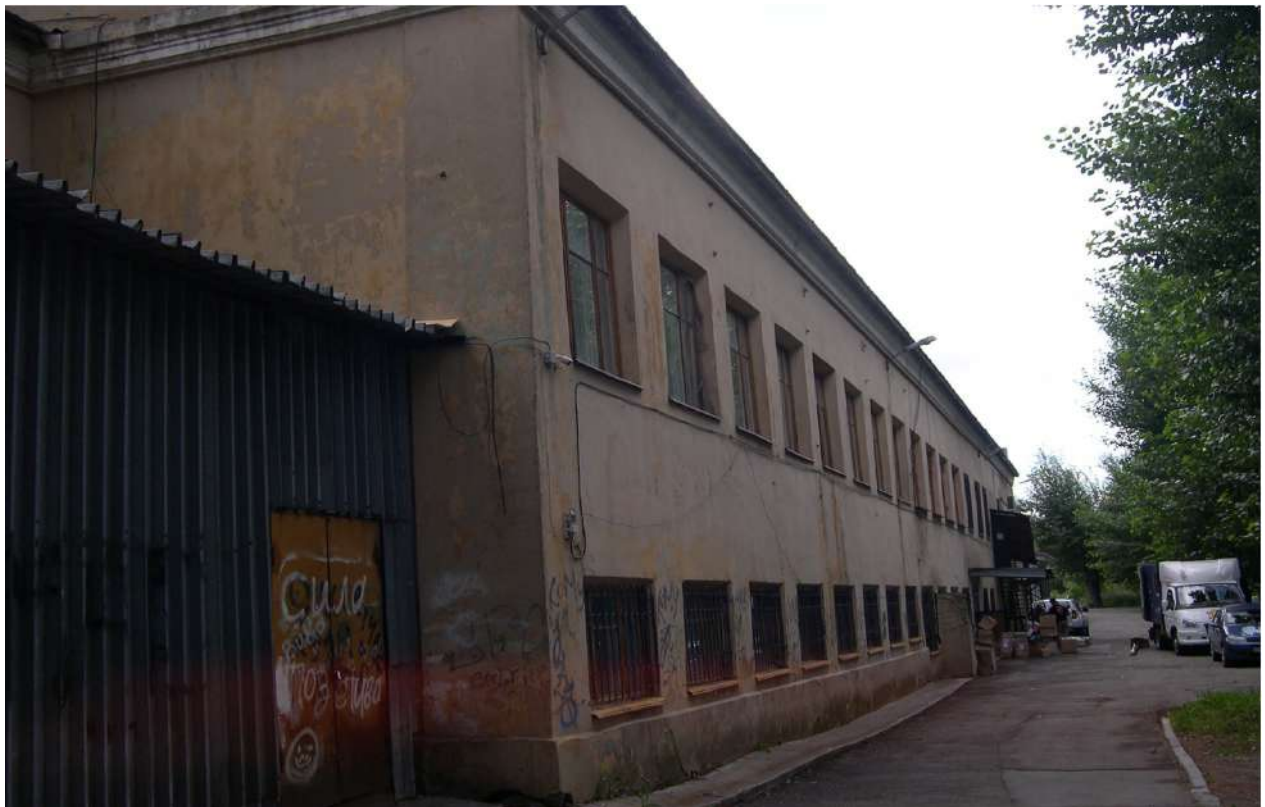
Рис.28 Вид на западный фасад с севера.
