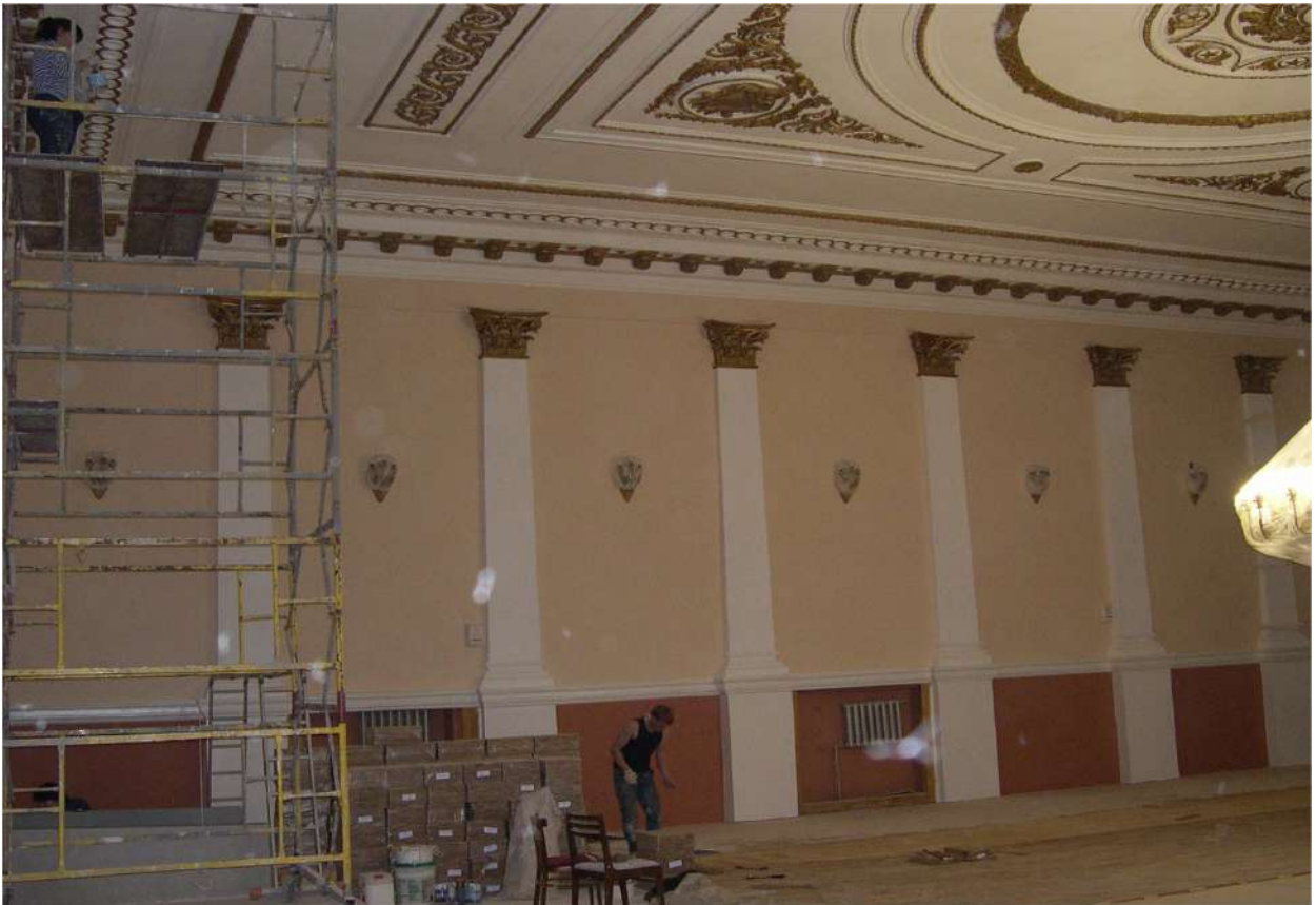
Рис.38 Вид на западную стену зрительного зала.
