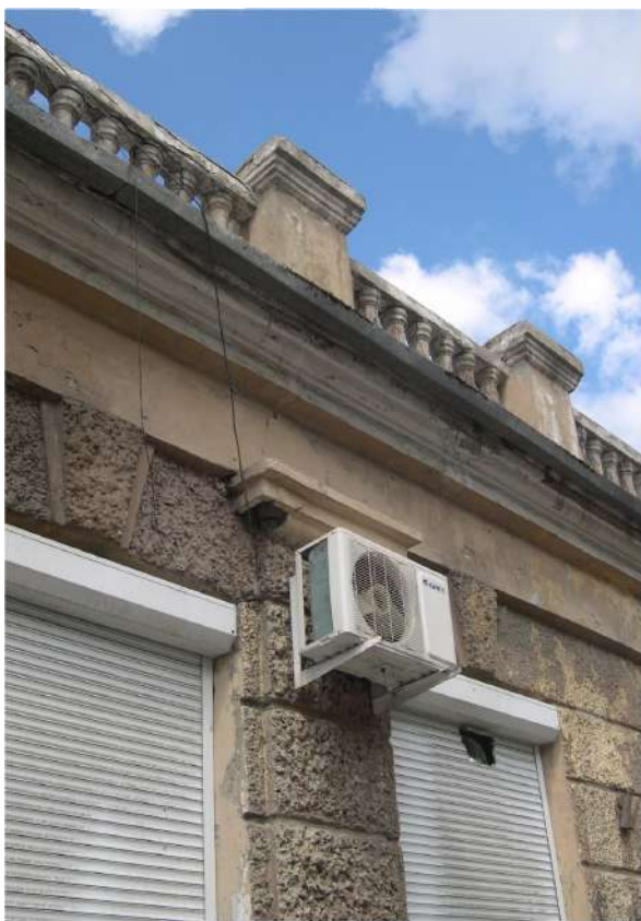
Рис.20 Фрагмент восточного фасада пристроя со стороны ул.Российской
