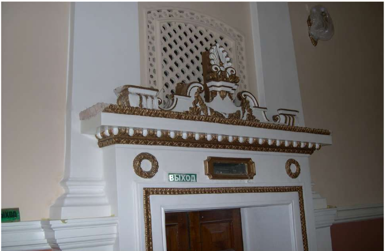
Рис.37 Вид на верхнюю часть выхода из зрительного зала.
