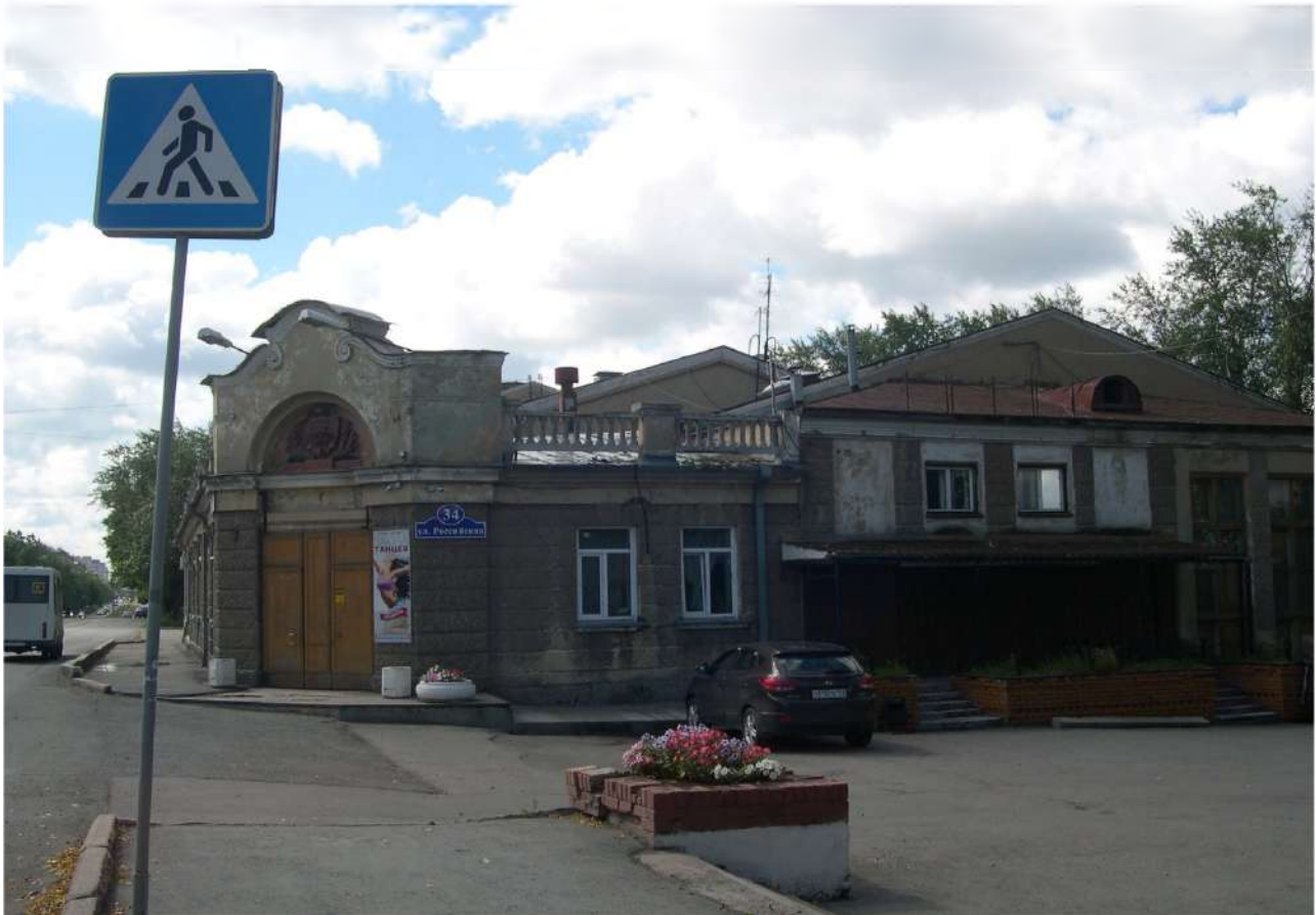
Рис. 2 Вид на главный фасад со стороны площади перед главным входом.
