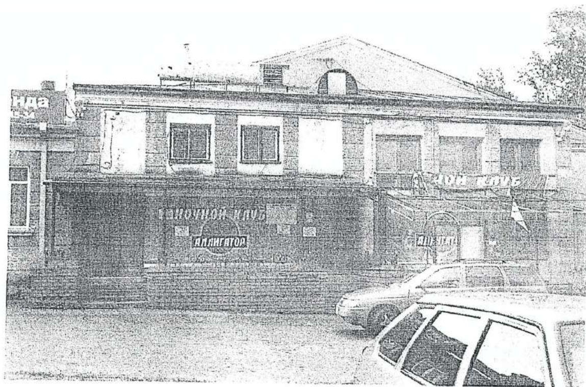
Фото 4. Северный фасад здания
