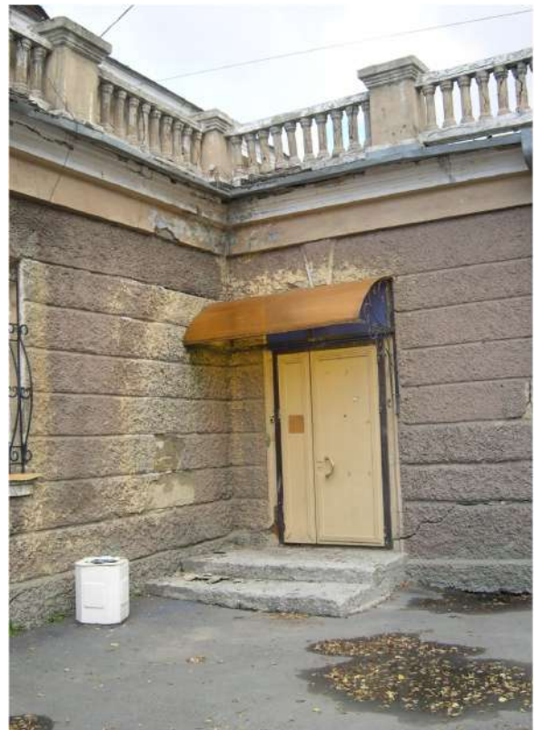
Рис.18 Южный вход пристроя со стороны восточного фасада.
