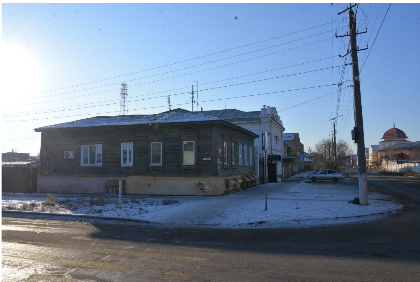
Фото 1. Вид на выявленный объект культурного наследия «Жилой дом», расположенный по адресу: Троицкий городской округ, г. Троицк, ул. Советская, 76
