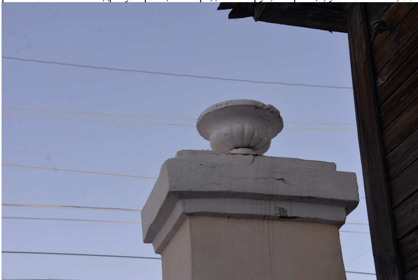
Фото 15. Вид на выявленный объект культурного наследия «Жилой дом», расположенный по адресу: Троицкий городской округ, г. Троицк, ул. Советская, 76
