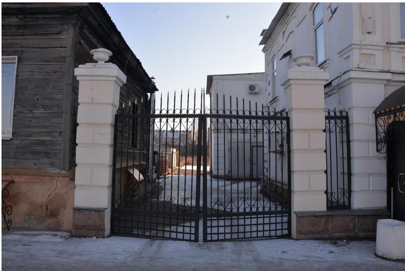
Фото 6. Вид на выявленный объект культурного наследия «Жилой дом», расположенный по адресу: Троицкий городской округ, г. Троицк, ул. Советская, 76
