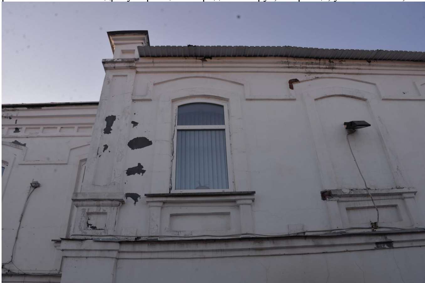
Фото 9. Вид на выявленный объект культурного наследия «Жилой дом», расположенный по адресу: Троицкий городской округ, г. Троицк, ул. Советская, 76
