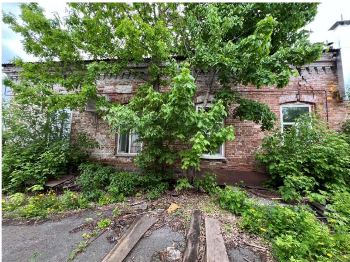
Рис. 4. Боковой, юго-западный фасад
