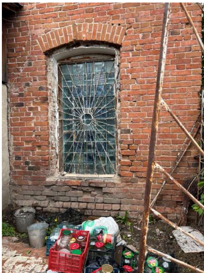
Рис. 8. Оконный проем на правом фланге дворового фасада
