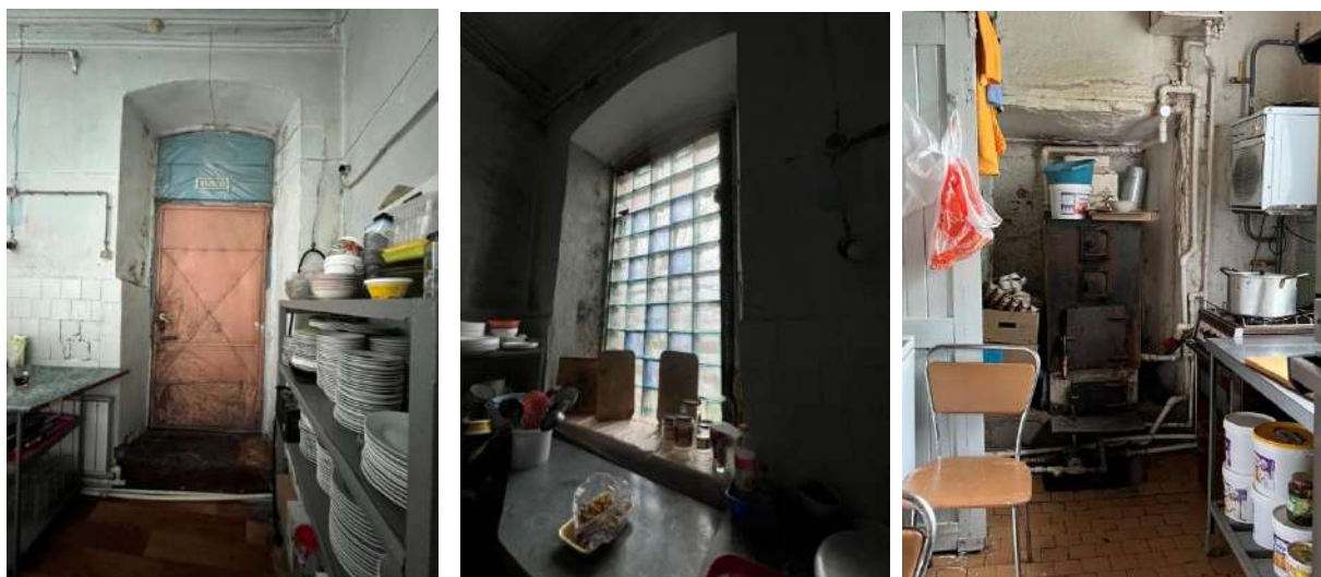
Рис. 11 а, б, в. Фрагмент интерьера. Подсобные помещения. Дверной проем. Оконный проем дворового фасада. Ниша на месте исторического входного проема
