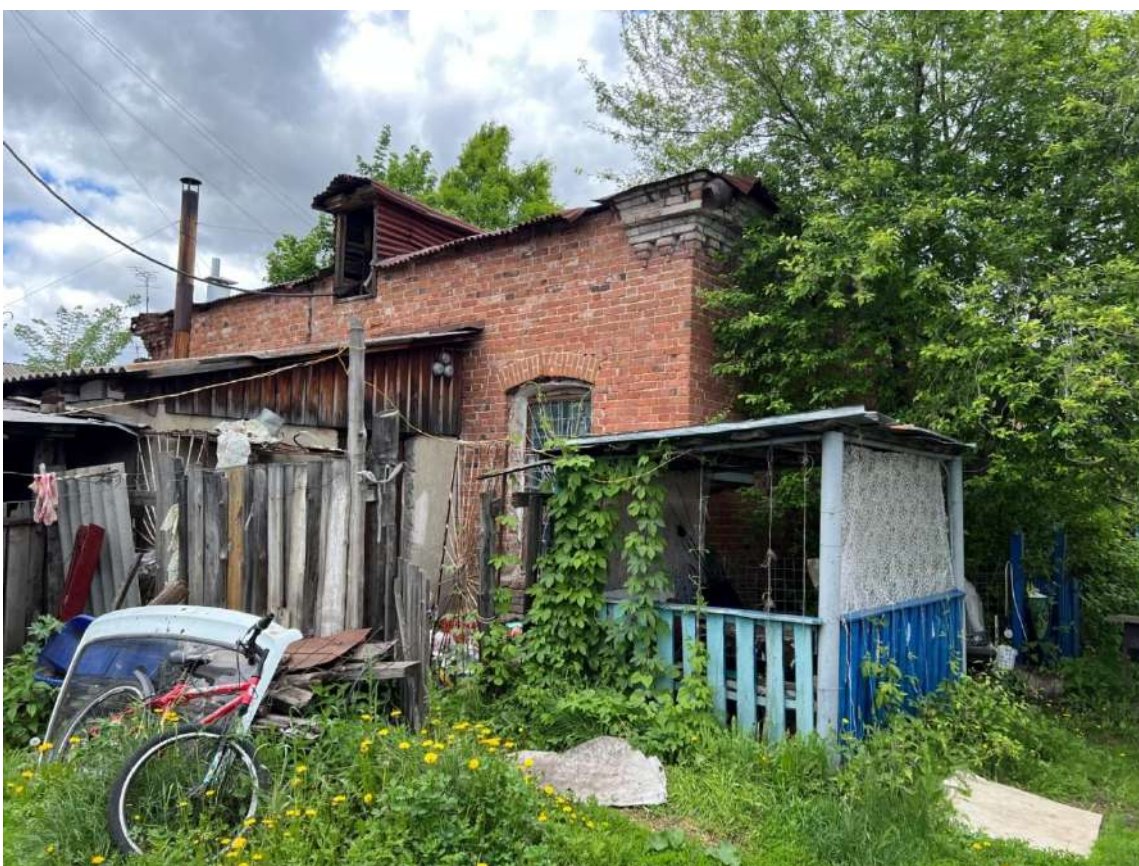
Рис. 7. Дворовый, юго-восточный фасад
