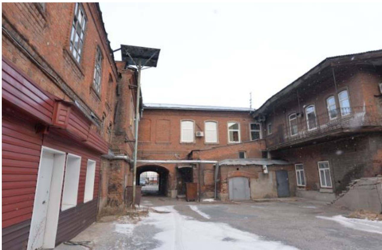
Фото 8. Вид на выявленный объект культурного наследия «Дом доходный», расположенный по адресу: Челябинская область, Троицкий городской округ, г. Троицк, ул. Советская, 66.
