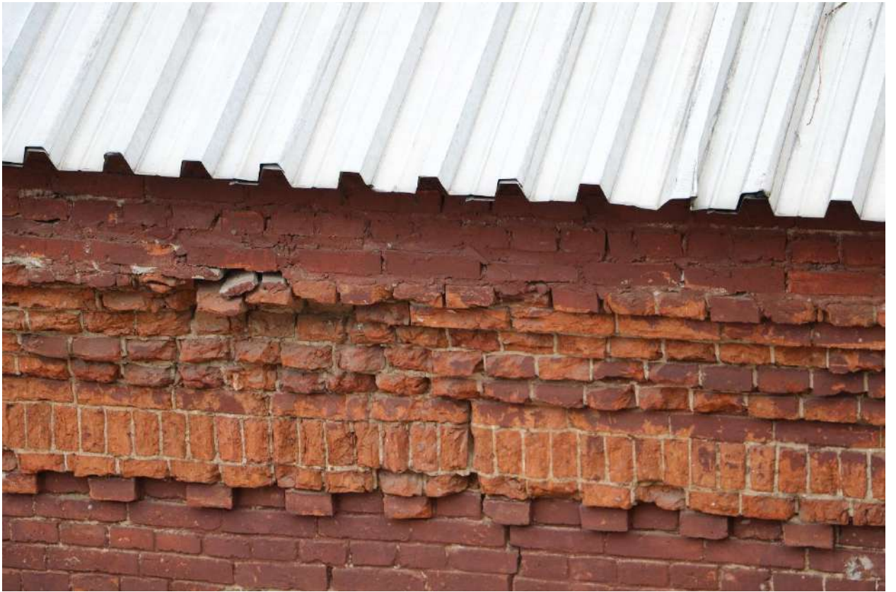
Фото 28. Выявленный объект культурного наследия. Фрагмент фасада и крыши.
