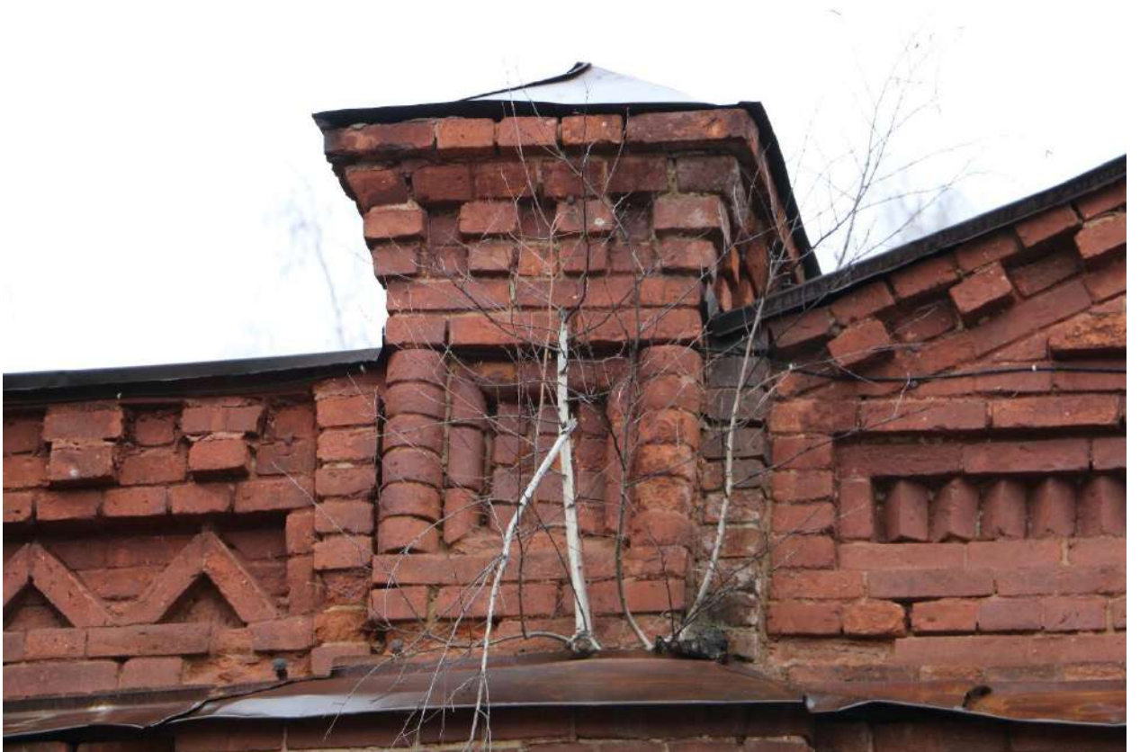
Фото 8. Выявленный объект культурного наследия. Фрагмент фасада и крыши.
