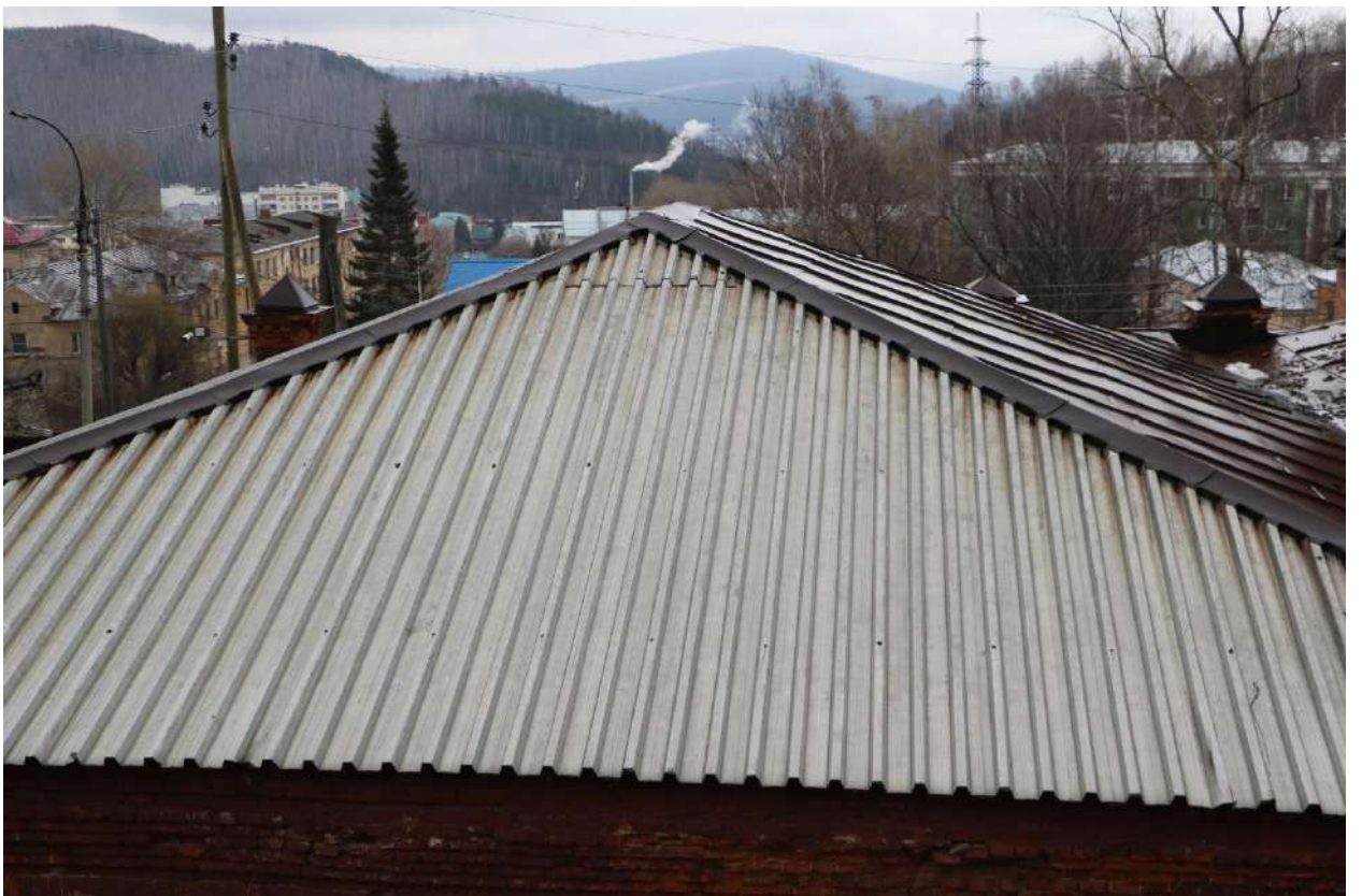
Фото 29. Выявленный объект культурного наследия. Крыша.
