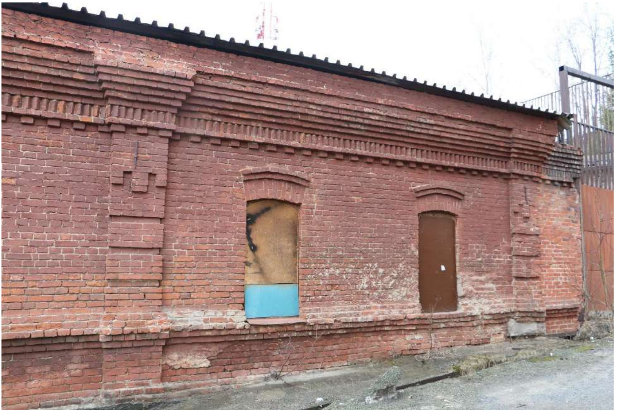
Фото 22. Выявленный объект культурного наследия. Фрагмент фасада с заложенными окнами.
