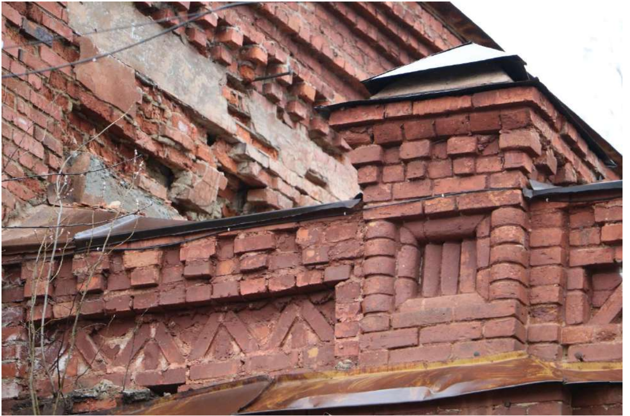
Фото 7. Выявленный объект культурного наследия. Фрагмент фасада и крыши.
