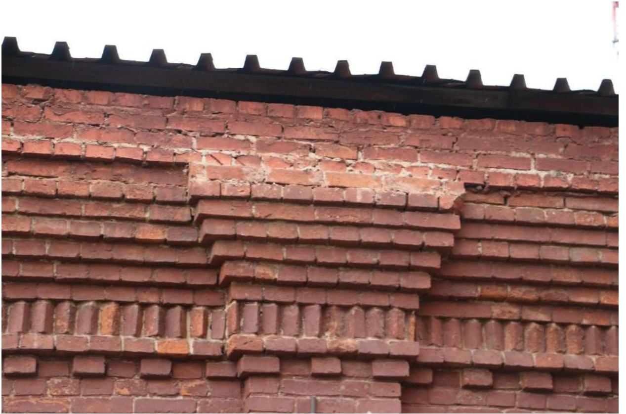
Фото 24. Выявленный объект культурного наследия. Фрагмент фасада.
