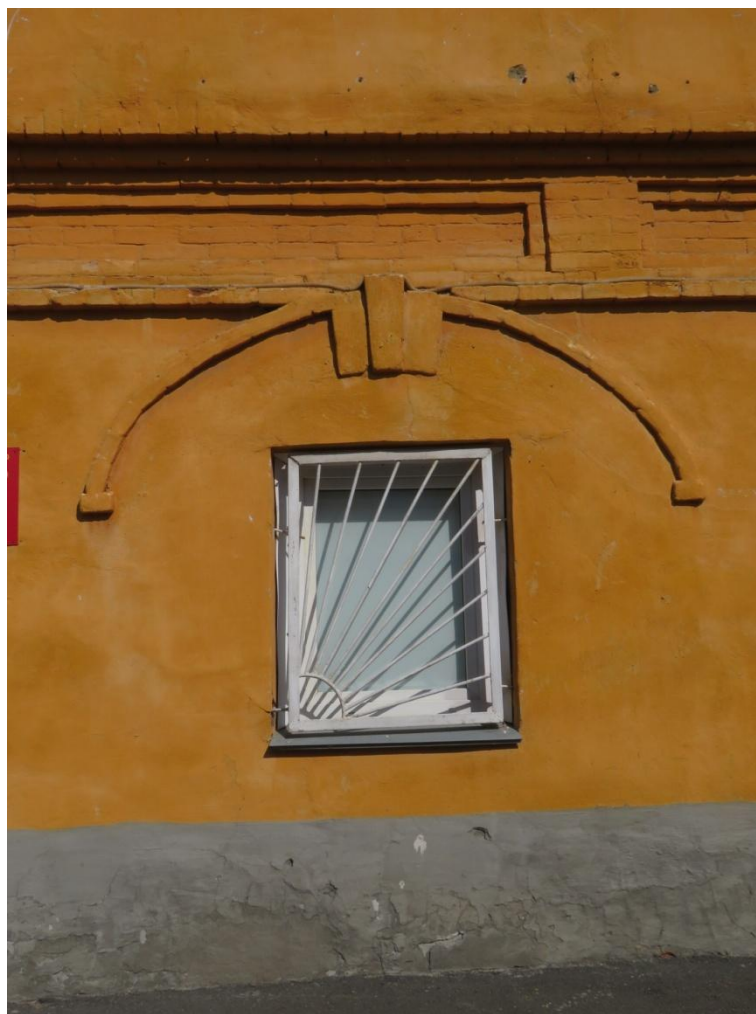
Рис. 6. Фрагмент декора лицевого, западного, фасада исторического здания. Обрамление проема
