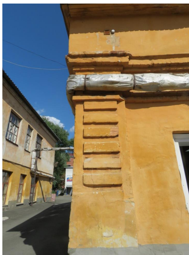
Рис. 7. Фрагмент лицевого, западного фасада исторического здания. Угловые лопатки
