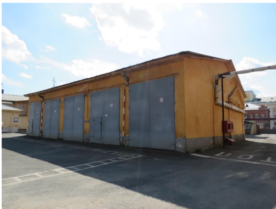
Рис. 3. Восточный и северный фасады исторического здания (северный фасад) и пристроенного с востока здания гаража (северный и восточный фасады). Вид с северо-востока
