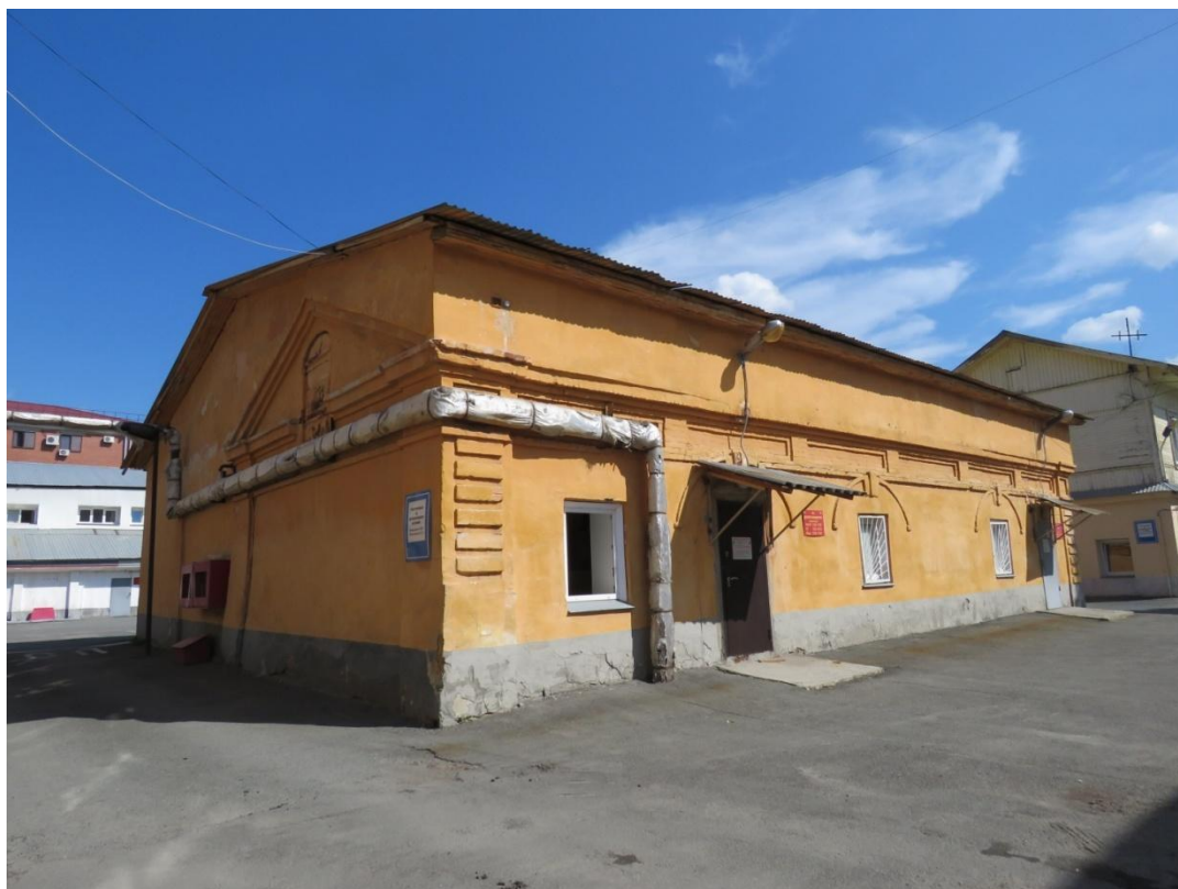
Рис. 4. Западный фасад исторического здания. Вид с северо-запада
