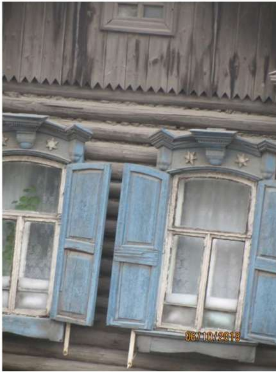
Фрагмент главного фасада
