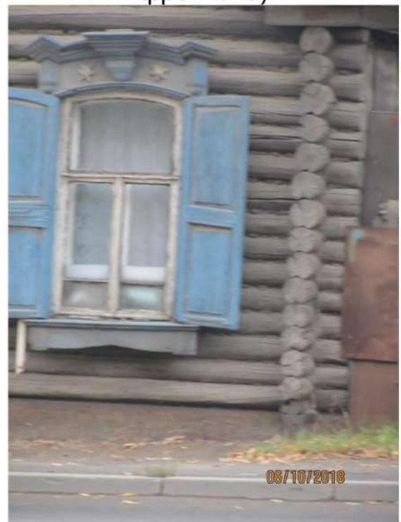
Фрагмент главного фасада
