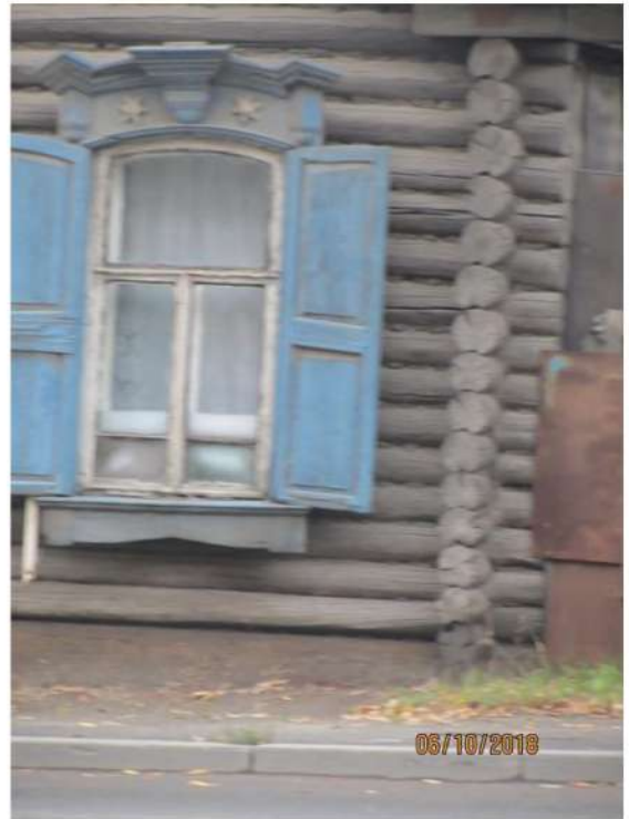
Фрагмент главного фасада
