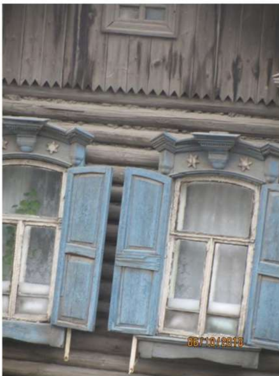
Фрагмент главного фасада
