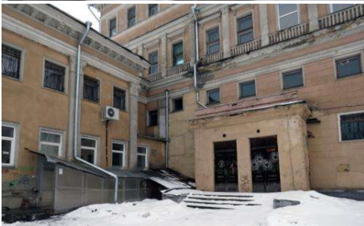
Рис. 34. Входные тамбуры на боковых, юго-восточном и северо-западном фасадах
