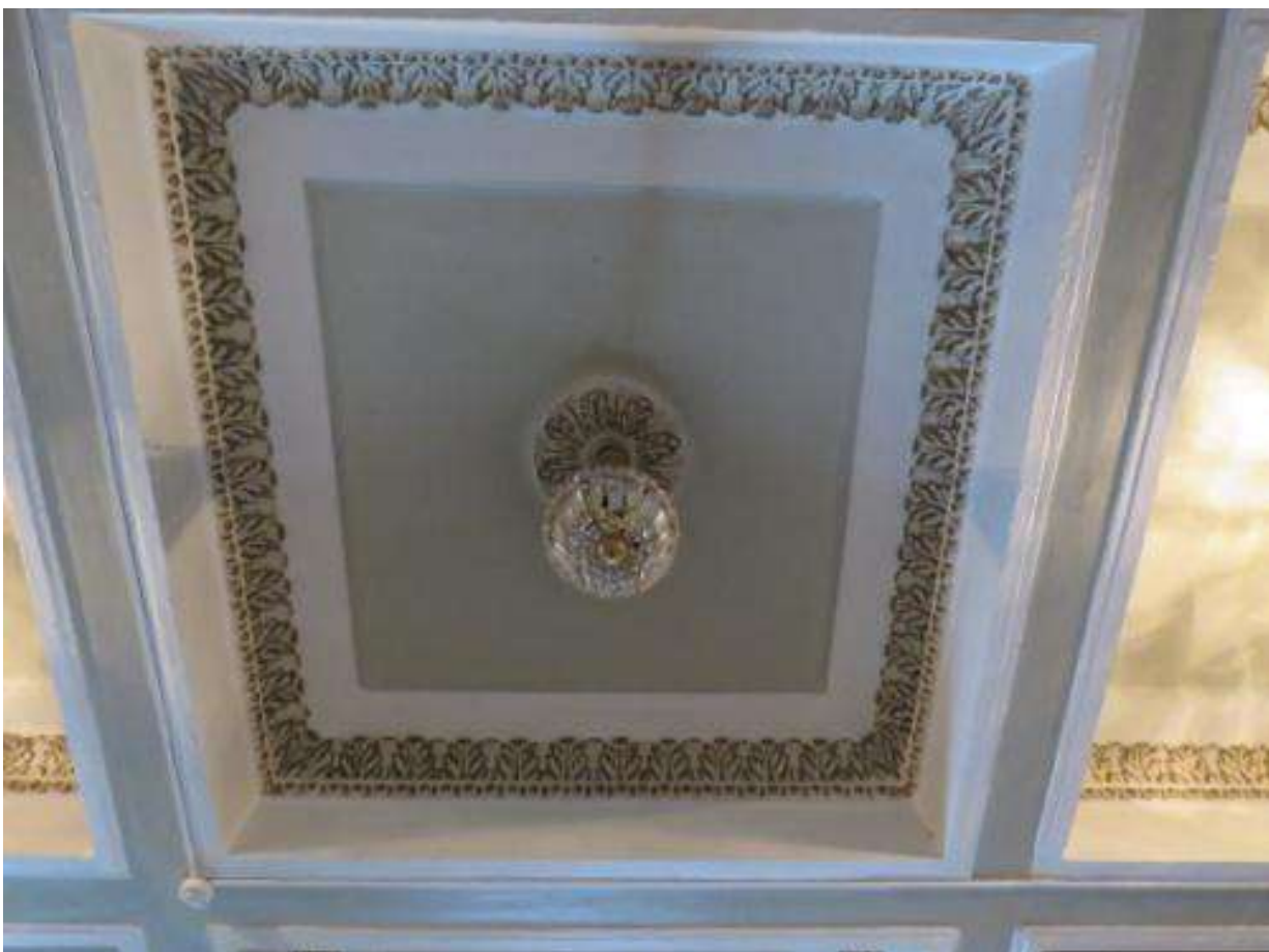
Рис. 41. Главный вестибюль. Оформление кессона.
