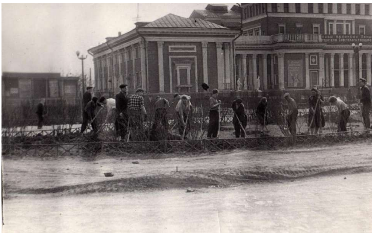
Рис. 25. Организация сквера перед главным фасадом Дворца культуры. Фото начала 1950-х гг. Источник: Архив музея завода «Станкомаш»
