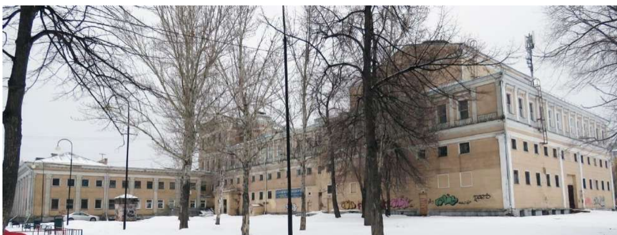
Рис. 32. Боковой, северо-западный фасад
