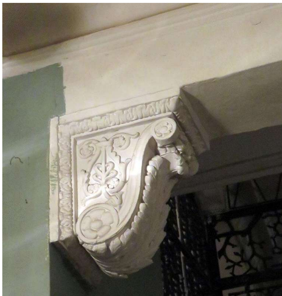
Рис. 45. Лестница в «Малахитовый зал». Архитектурно-декоративное решение кронштейна
