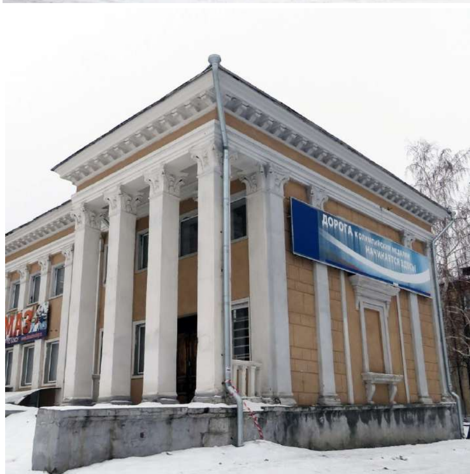
Рис. 13. Портики северо-западного и юго-восточного крыла.
