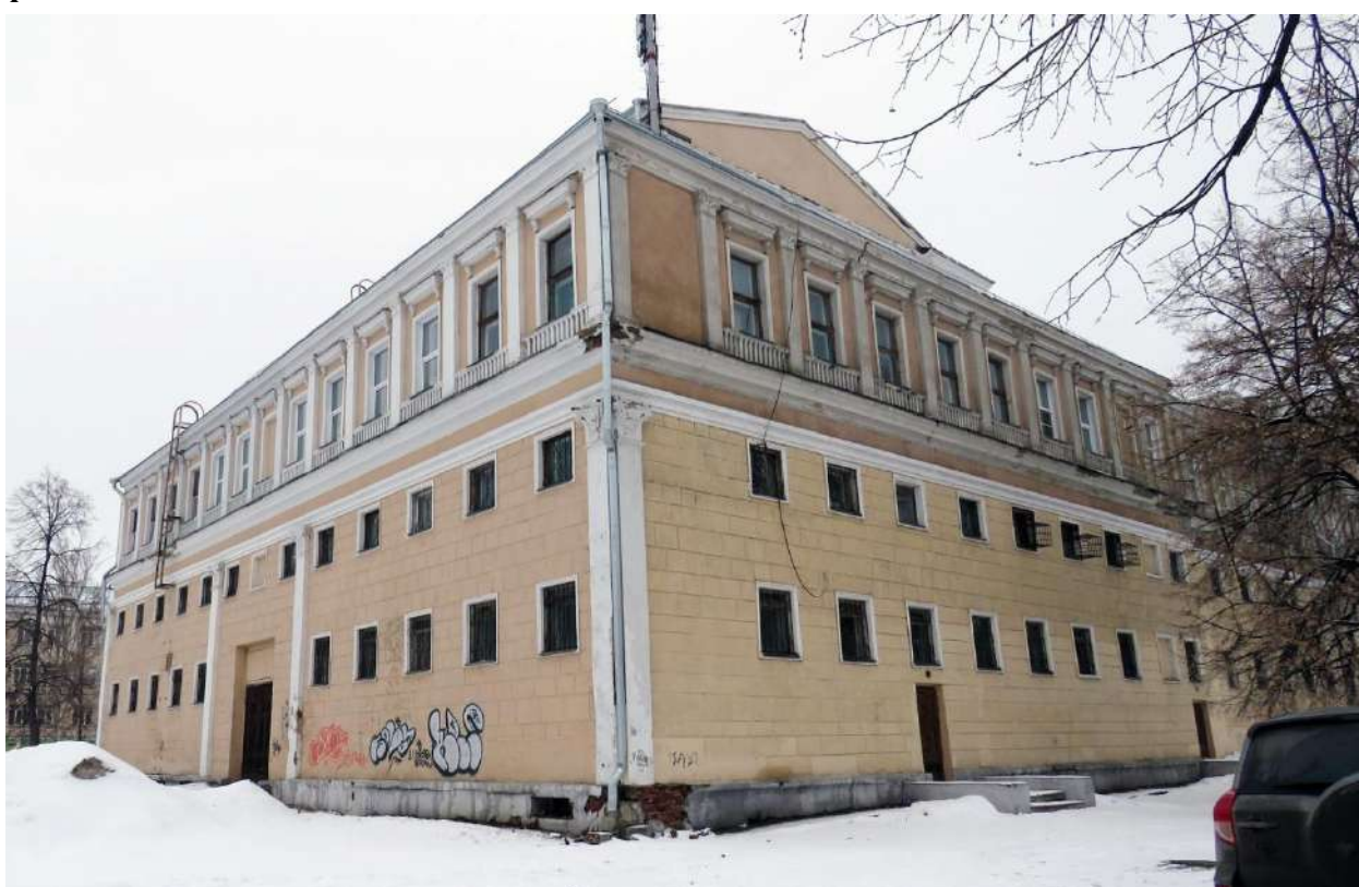
Рис. 36. Фрагмент бокового, юго-восточного фасада и дворового, юго-западного фасада
