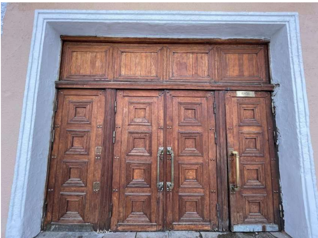
Рис. 16. Входной проем и заполнение дверного проема главного входа
