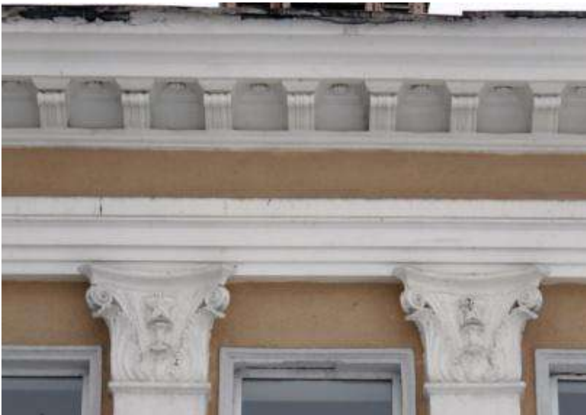
Рис. 20. Решение капителей пилястр в межоконных простенках боковых крыльев
