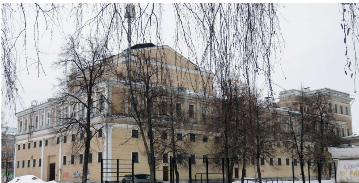
Рис. 31. Боковой, юго-восточный фасад
