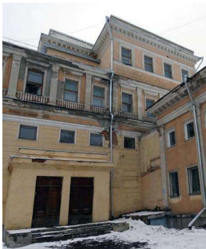
Рис. 28. «Карман» в стыке боковых корпусов и основного корпуса (на стыке юго-восточного крыла с основным корпусом – заложен).
