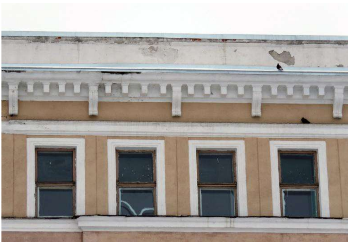
Рис. 24. Оконные проемы четвертого этажа повышенного северо-восточного объема
