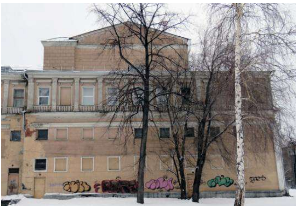
Рис. 33. Фрагменты бокового, северо-западного фасада
