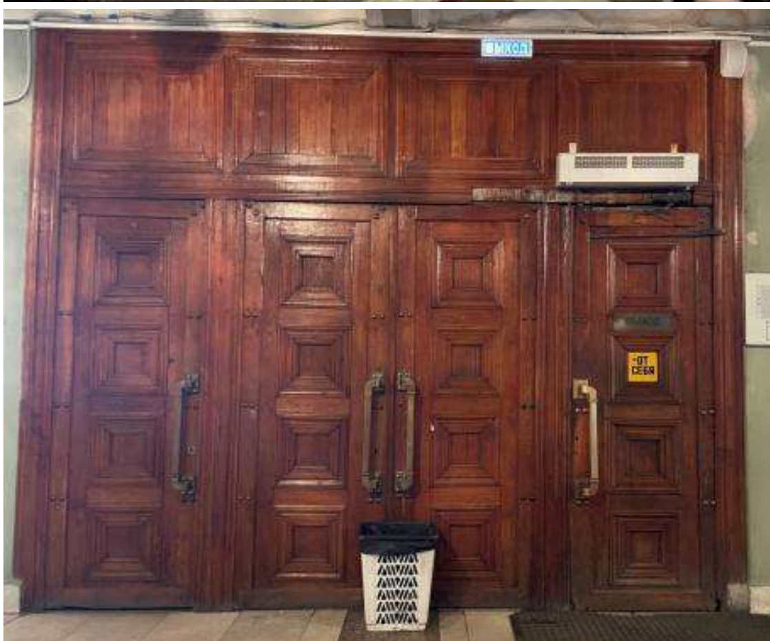
Рис. 33. Тамбур главного входа и входная дверь в главный вестибюль
