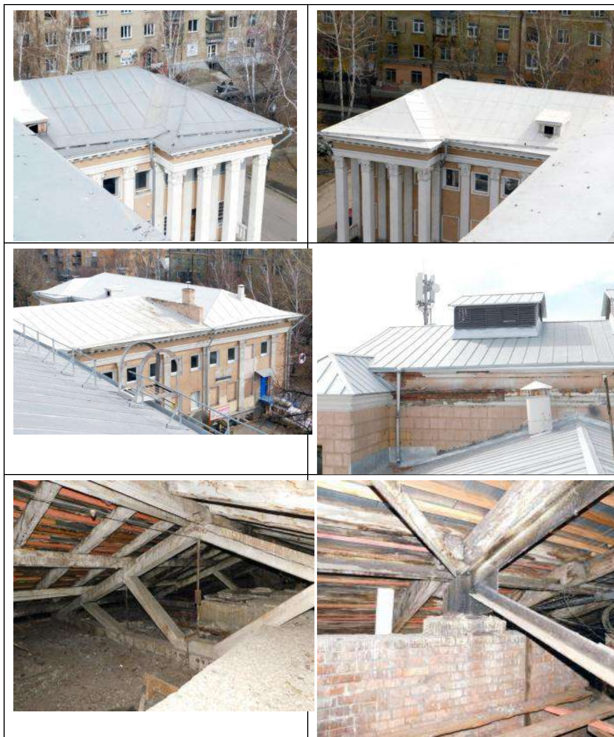
Рис. 32. Кровля и стропильная система крыши.
