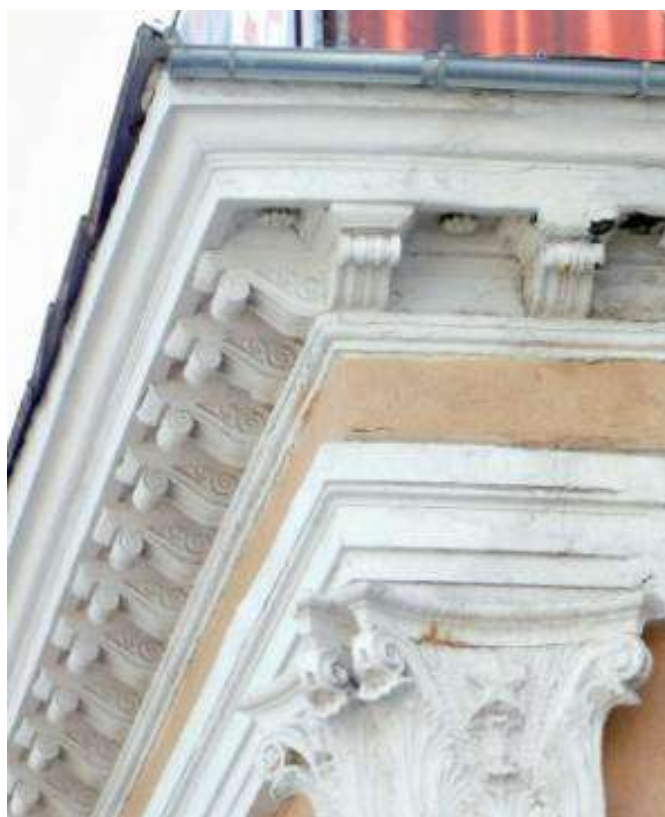
Рис. 21. Решение венчающего антаблемента двухэтажной части здания (портик главного входа, объемы, фланкирующие портик главного входа, боковые крылья (все фасады))
