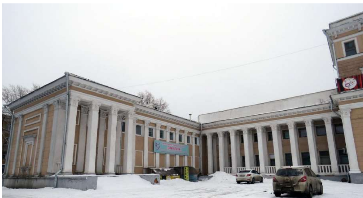
Рис. 8. Юго-восточное крыло. Главный фасад
