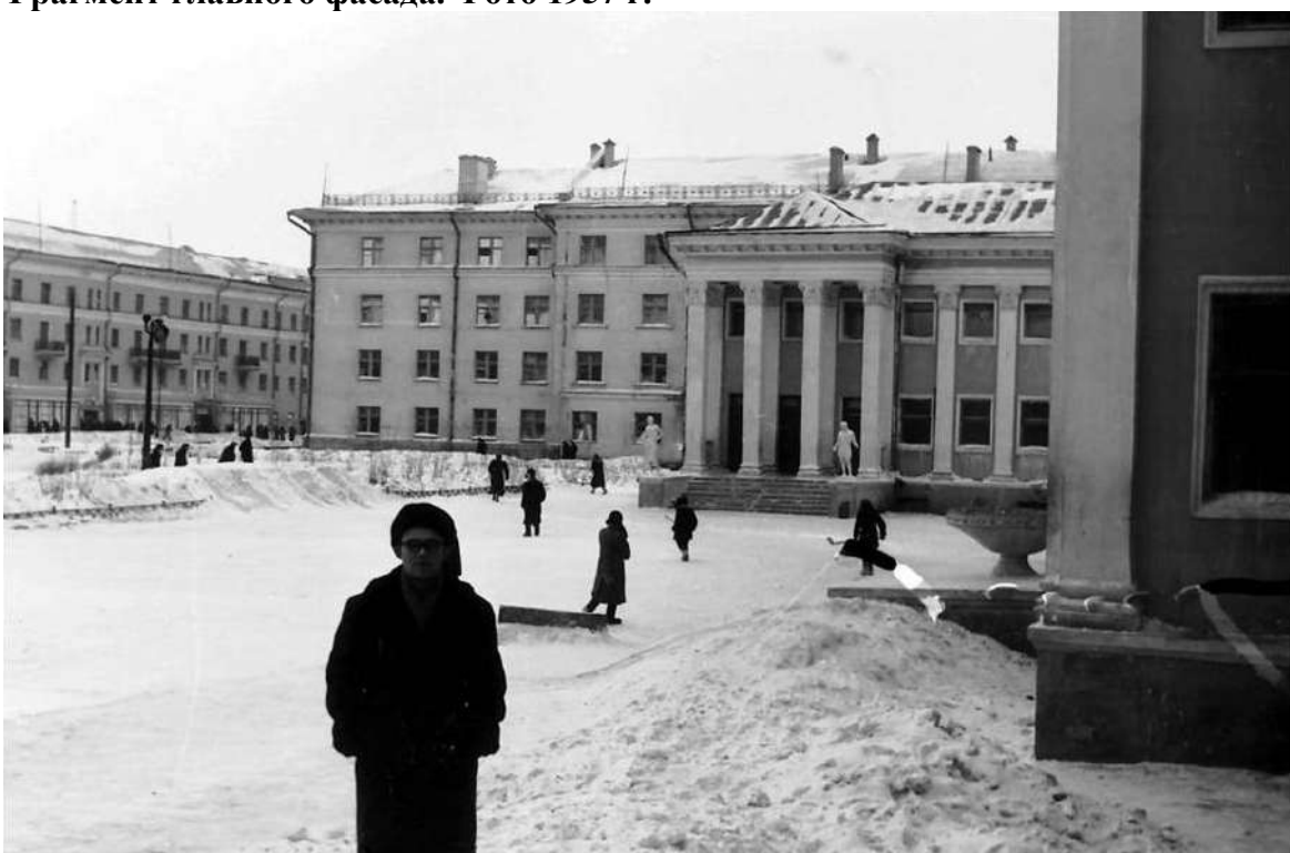
Рис. 23. Дворец культуры завода им. Серго Орджоникидзе («Станкомаш»). Фрагмент главного фасада. Фото 1956 г. Источник: https://pastvu.com/p/572093
