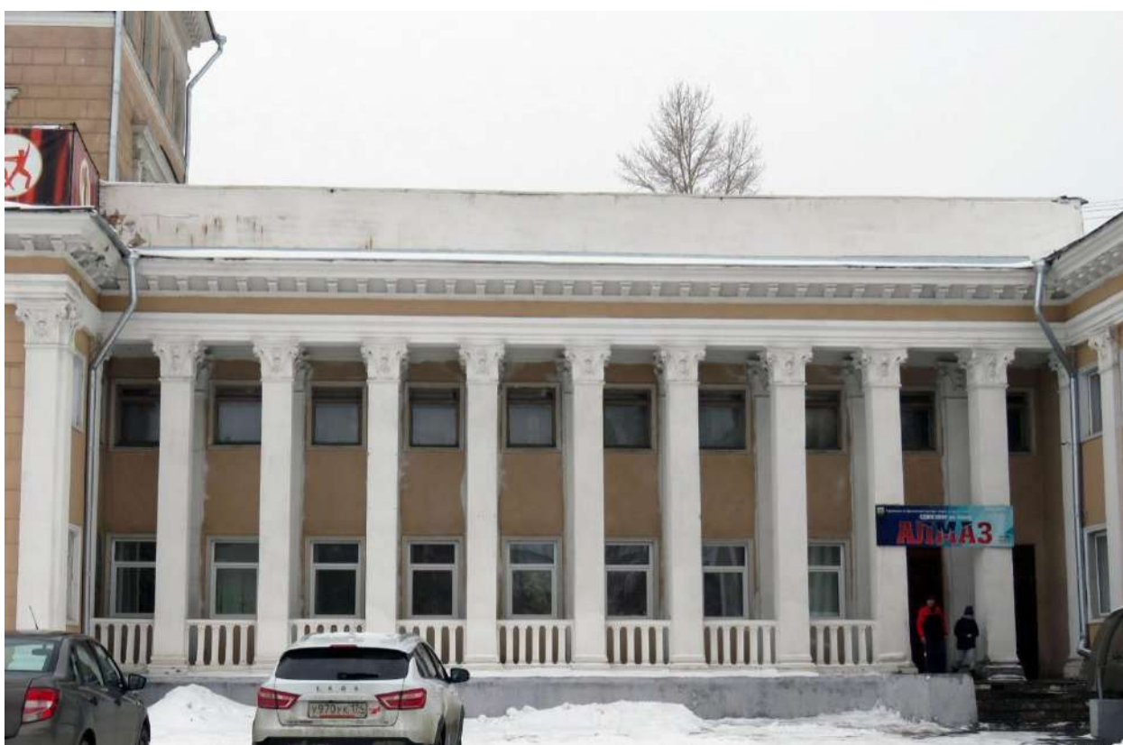
Рис. 12. Продольный корпус северо-западного крыла. Главный фасад
