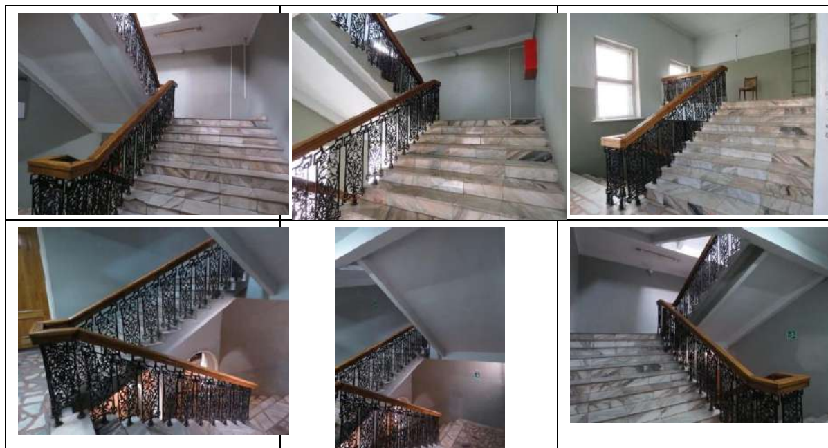
Рис. 89. Две лестницы из главного вестибюля на 4 этаж
