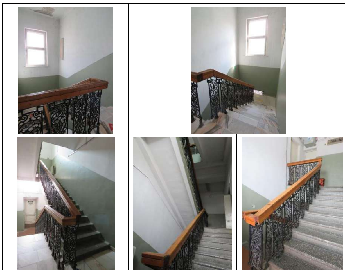
Рис. 90. Две лестницы восточного продольного коридора между цокольным и вторым этажами
