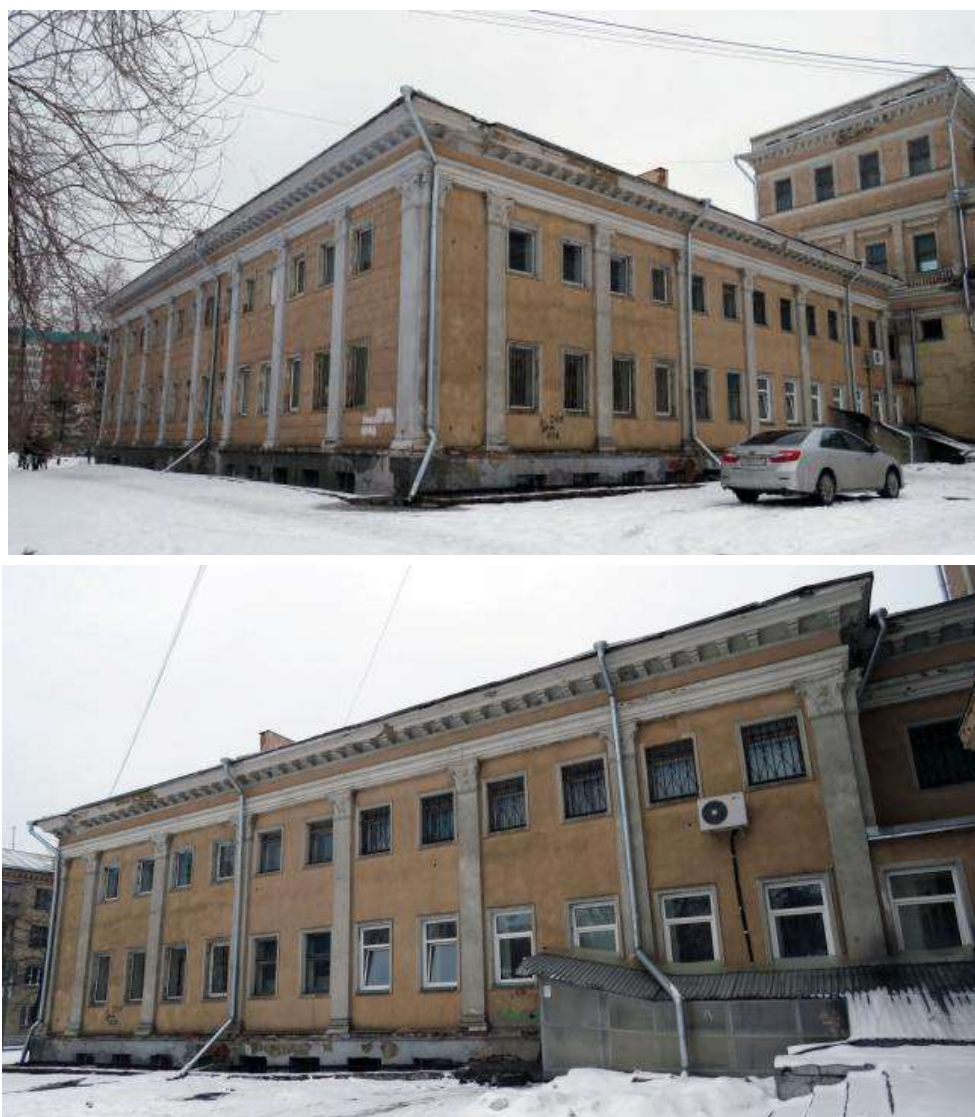
Рис. 27. Боковой и дворовый фасада северо-западного крыла.
