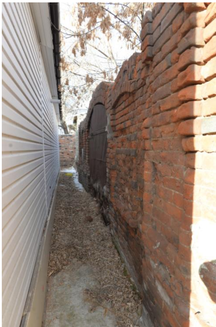
Фото 17. Вид на выявленный объект культурного наследия «Жилой дом», расположенный по адресу: Челябинская область, Троицкий городской округ, г. Троицк, ул. им. Степана Разина, 18.
