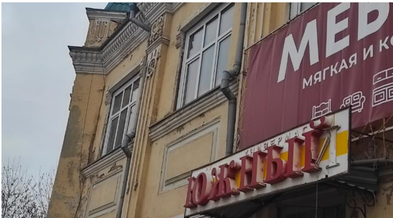
Фото 4. Вид на выявленный объект культурного наследия «Магазин Стахеева», расположенный по адресу: Челябинская область, Миасский городской округ, г. Миасс, ул. Ленина, 2.
