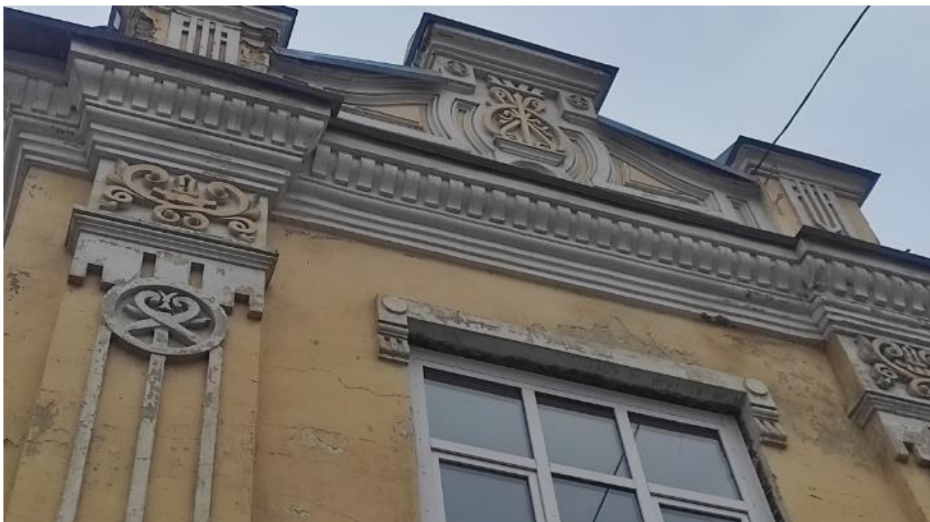
Фото 7. Вид на выявленный объект культурного наследия «Магазин Стахеева», расположенный по адресу: Челябинская область, Миасский городской округ, г. Миасс, ул. Ленина, 2.
