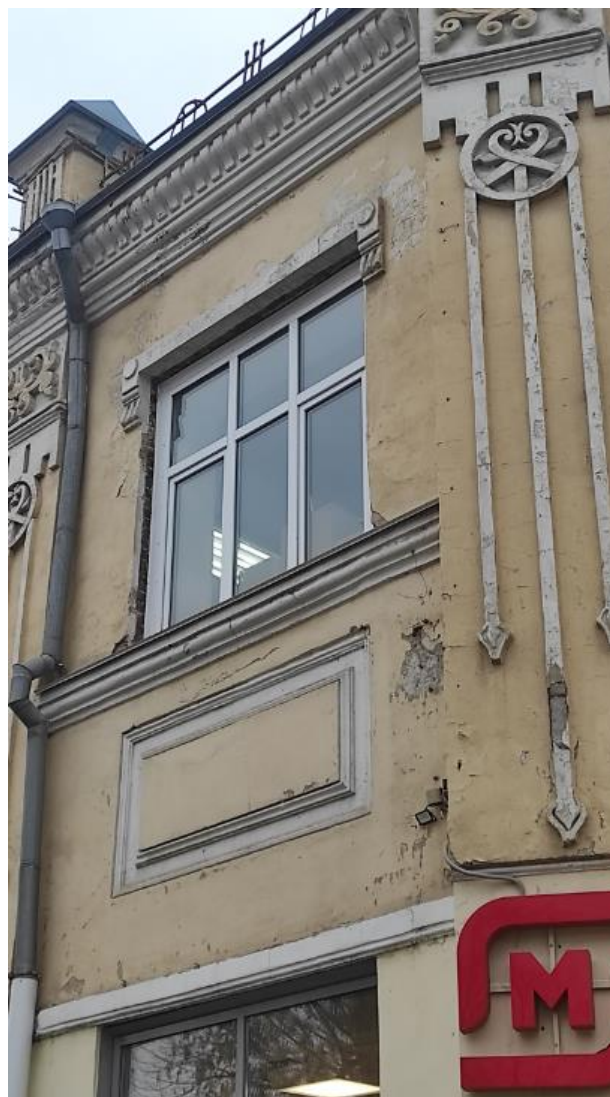
Фото 15. Вид на выявленный объект культурного наследия «Магазин Стахеева», расположенный по адресу: Челябинская область, Миасский городской округ, г. Миасс, ул. Ленина, 2.
