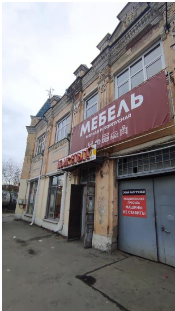
Фото 1. Вид на выявленный объект культурного наследия «Магазин Стахеева», расположенный по адресу: Челябинская область, Миасский городской округ, г. Миасс, ул. Ленина, 2.
