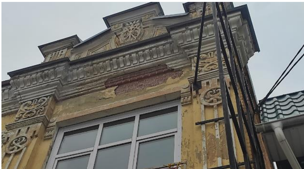
Фото 2. Вид на выявленный объект культурного наследия «Магазин Стахеева», расположенный по адресу: Челябинская область, Миасский городской округ, г. Миасс, ул. Ленина, 2.
