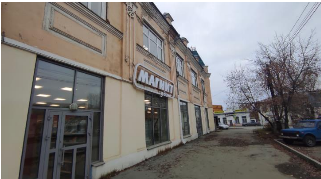
Фото 10. Вид на выявленный объект культурного наследия «Магазин Стахеева», расположенный по адресу: Челябинская область, Миасский городской округ, г. Миасс, ул. Ленина, 2.
