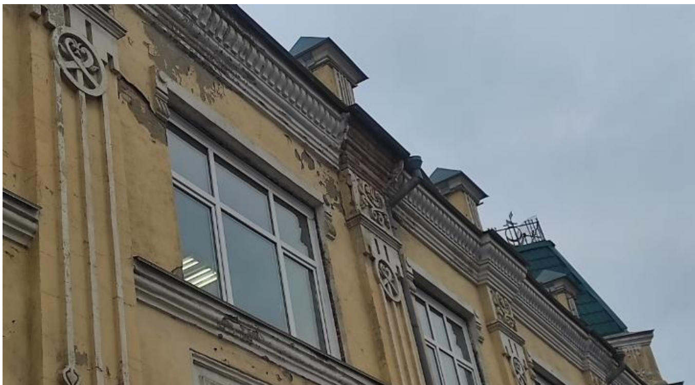
Фото 8. Вид на выявленный объект культурного наследия «Магазин Стахеева», расположенный по адресу: Челябинская область, Миасский городской округ, г. Миасс, ул. Ленина, 2.
