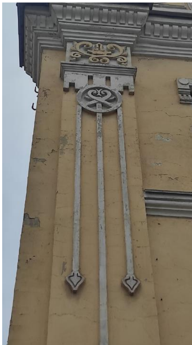
Фото 6. Вид на выявленный объект культурного наследия «Магазин Стахеева», расположенный по адресу: Челябинская область, Миасский городской округ, г. Миасс, ул. Ленина, 2.
