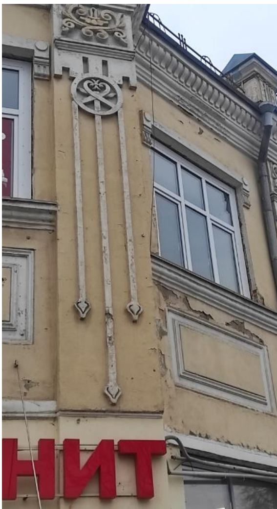
Фото 14. Вид на выявленный объект культурного наследия «Магазин Стахеева», расположенный по адресу: Челябинская область, Миасский городской округ, г. Миасс, ул. Ленина, 2.
