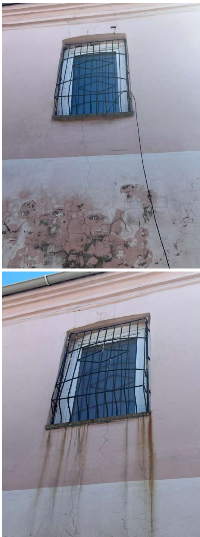
Рис. 6 а, б. Фрагменты бокового, западного фасада. Оконные проемы второго этажа лестничного объема
