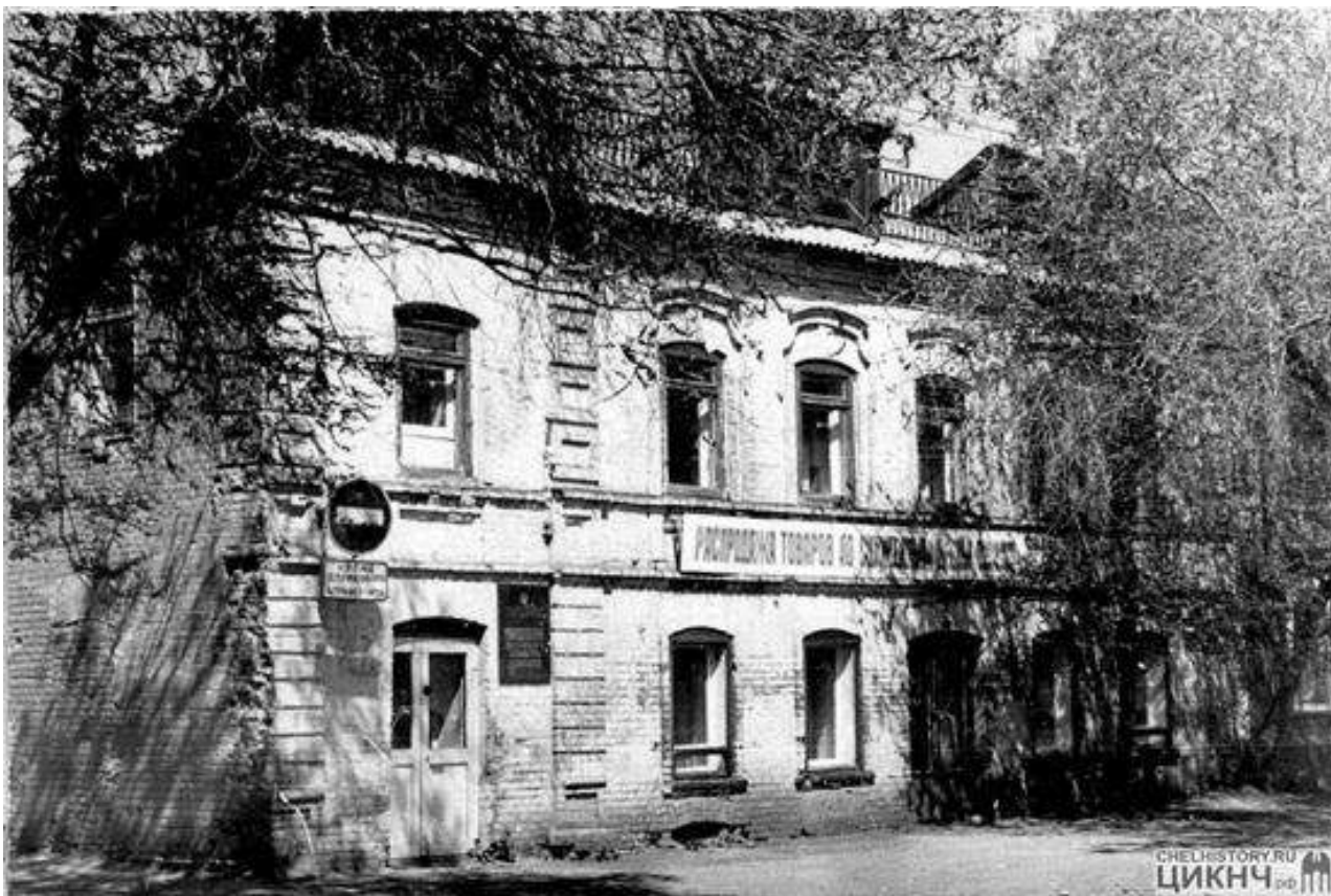
Рис. 20. Выявленный ОКН «Двухэтажный каменный дом Сухарева», расположенный по адресу ул. Маркса, 72 а. Фото 1990 г. Источник: из фондов Центра историко-культурного наследия Челябинска
