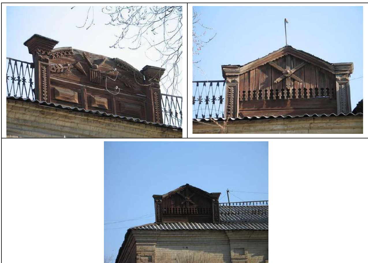
Рис. 22. Деревянные парапетные стенки на кровле (утрачены ориентировочно в 2009 г.). Фото 2005 г. Г.Х. Самигулов
