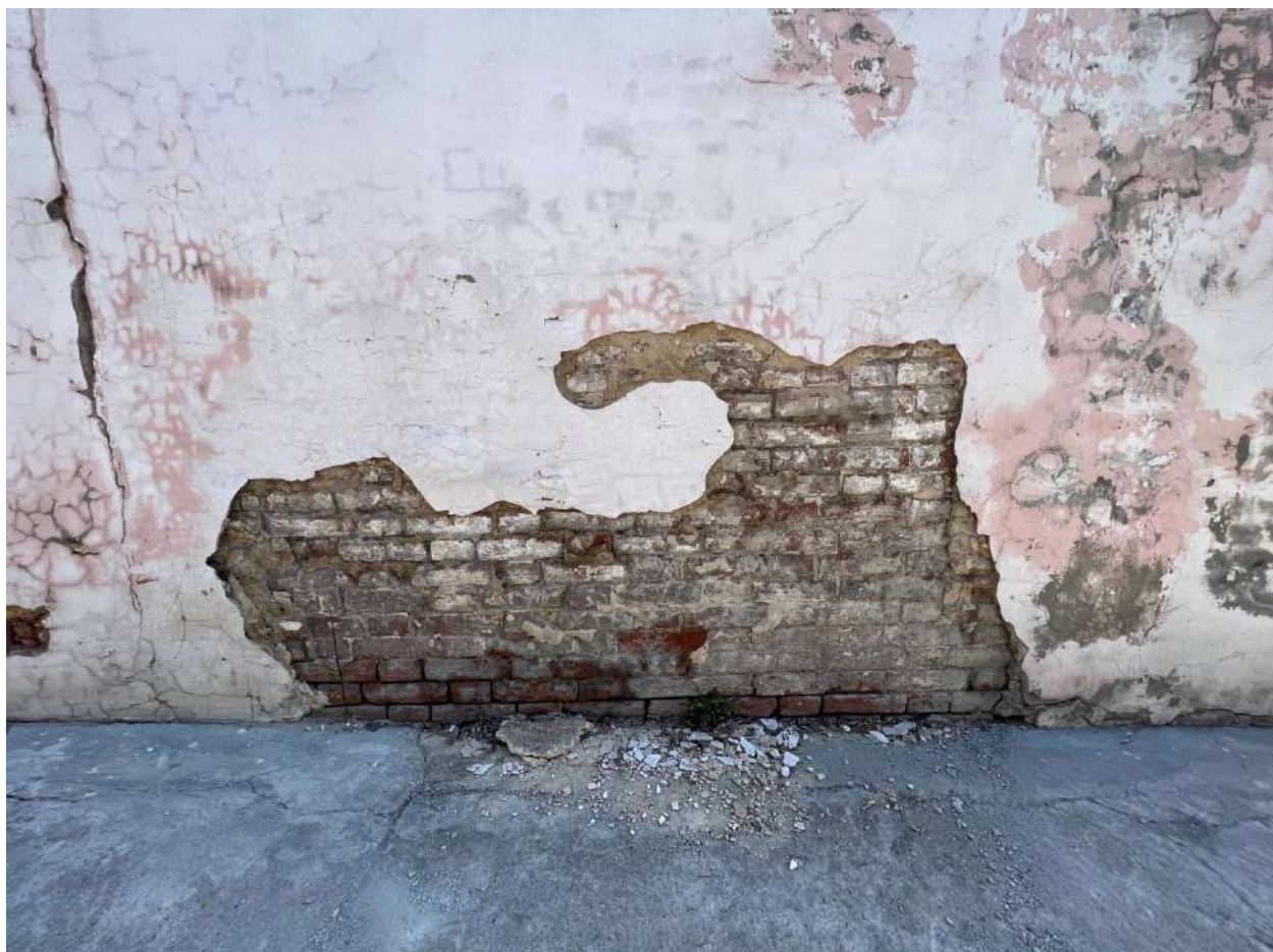
Рис. 11. Кирпичная кладка стен здания
