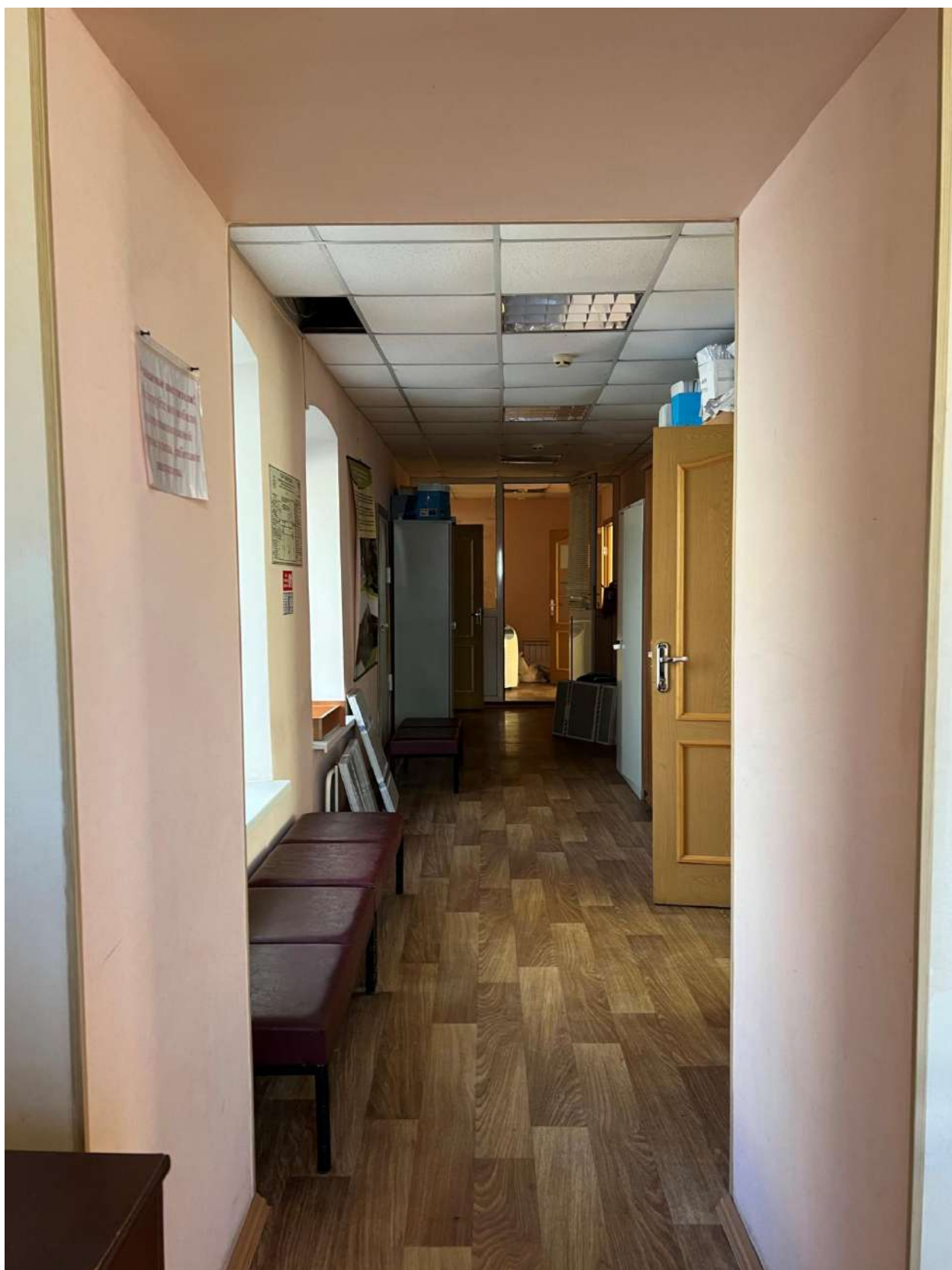
Рис. 13. Фрагменты интерьера второго этажа. Продольный коридор
