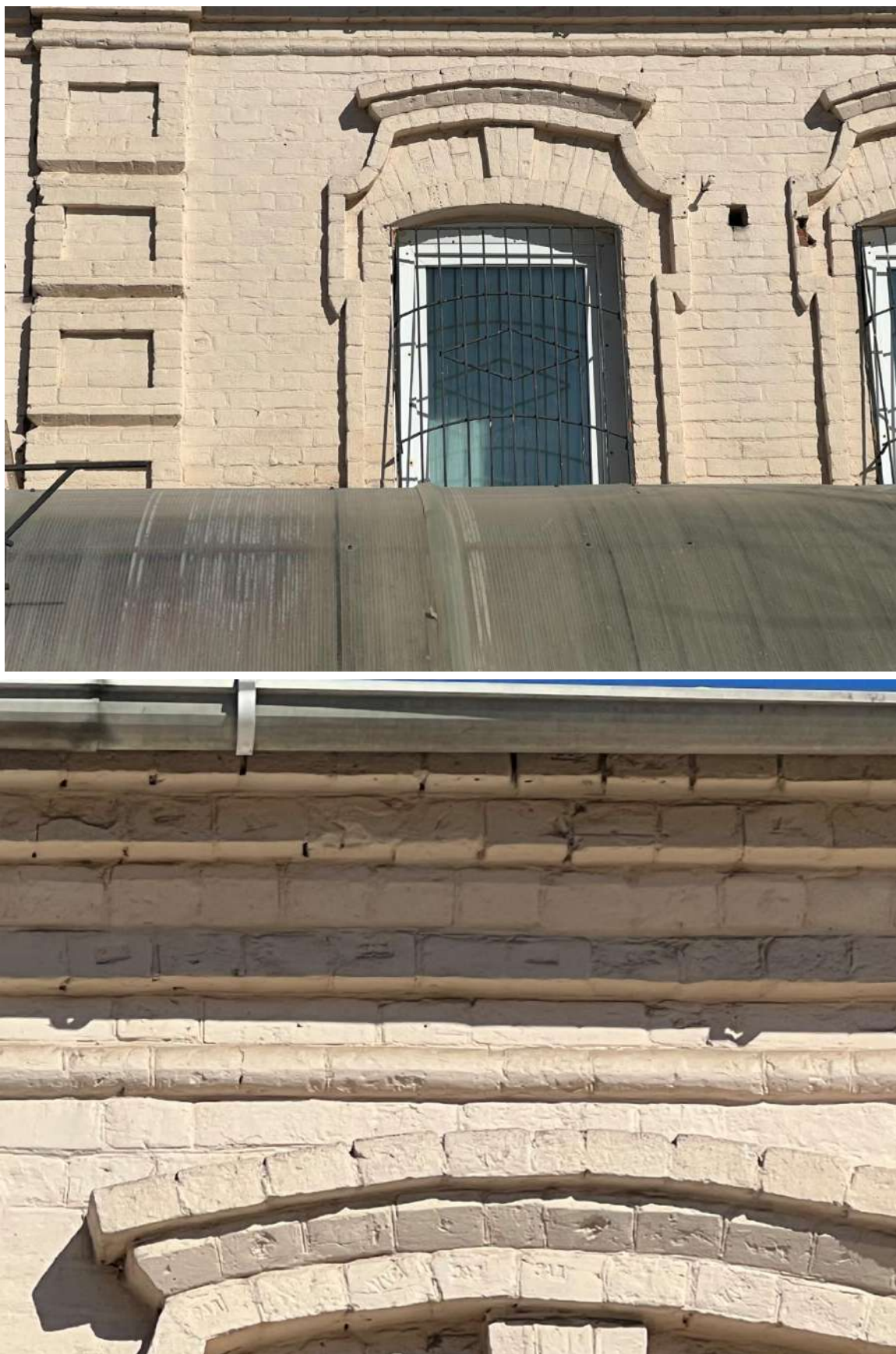
Рис. 5 а, б. Фрагменты декоративного решения главного, южного фасада
