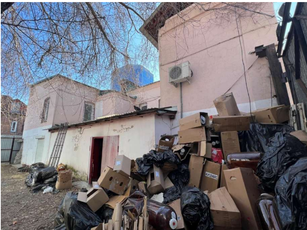
Рис. 7. Дворовый, северный фасад. Вид с северо-запада
