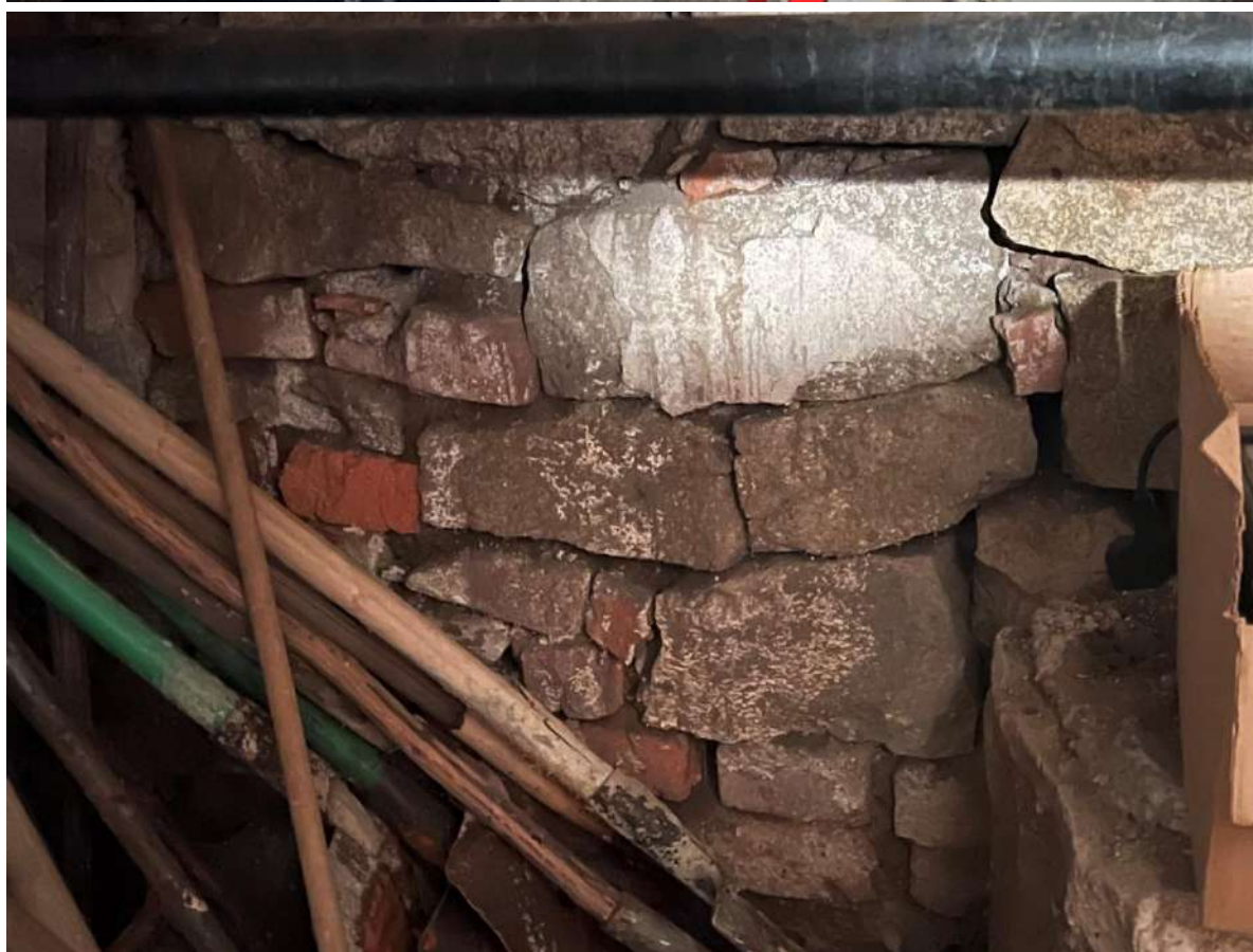
Рис. 10 а, б. Подвал. Бутовая кладка стен подвала (внизу)
