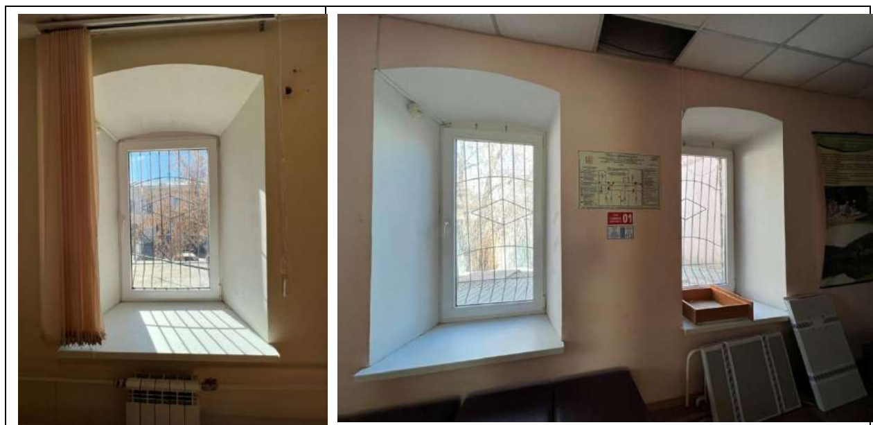
Рис. 16. Оконные проемы второго этажа
