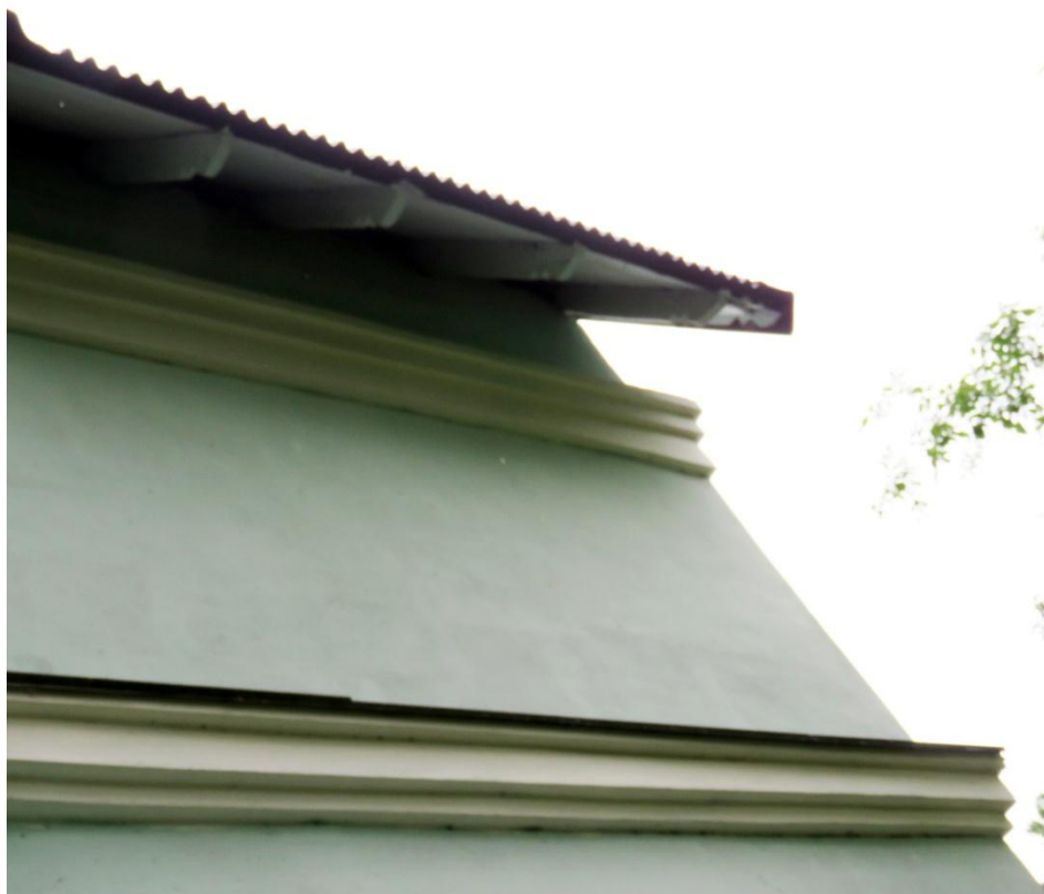
Рис. 8. Фрагмент декора фасадов (междуэтажный и венчающий профилированные карнизы) и свесы крыши на фигурных деревянных кронштейнах
