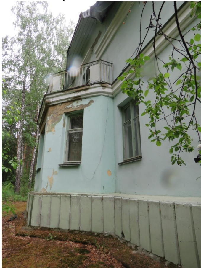
Рис. 4. Фрагмент бокового, юго-восточного фасада
