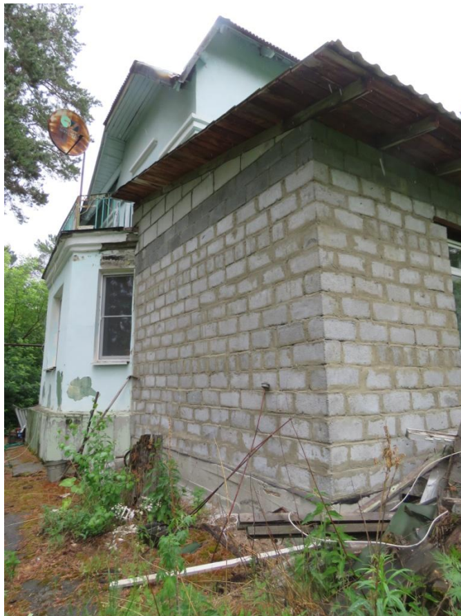
Рис. 6. Дворовый, юго-западный фасад. Вид с запада. Пристрой к левому флангу.
