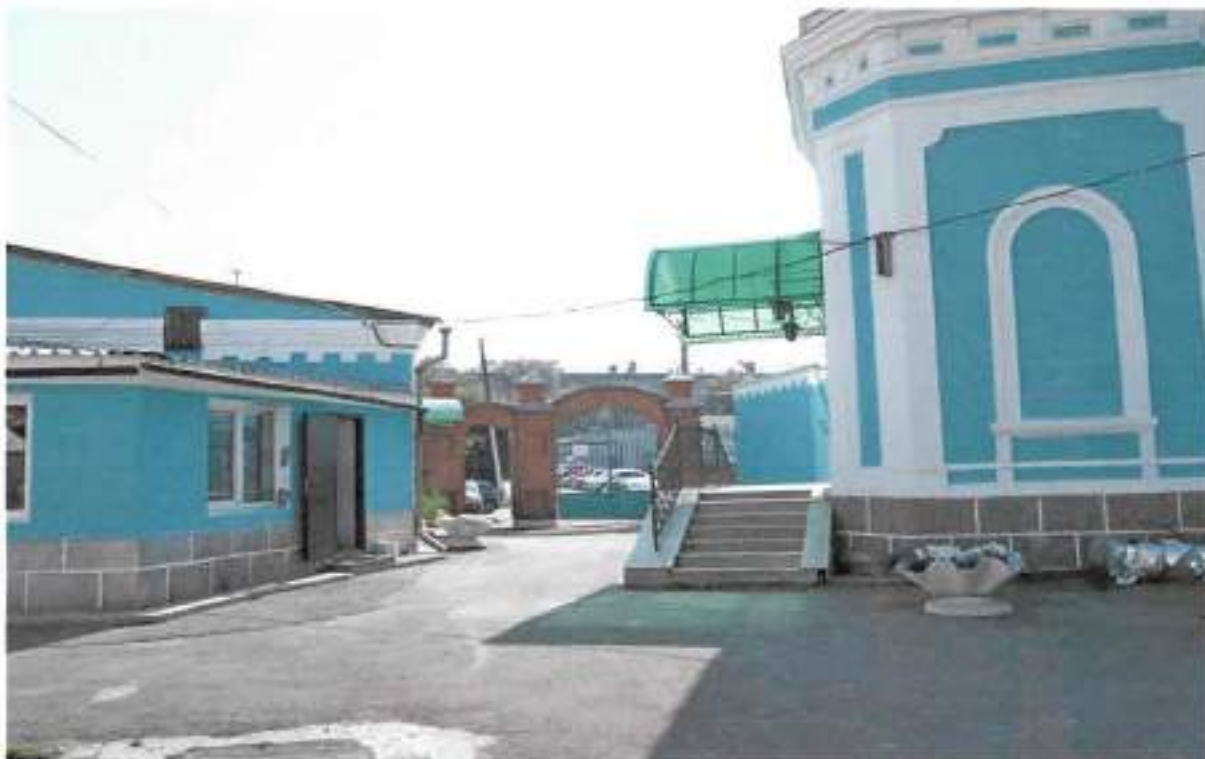
Фото 11. Главный вход в здание мечети, расположенный с северо-восточной стороны
