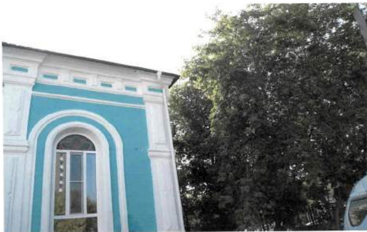
Фото 4. Фрагмент северо-западного фасада.
