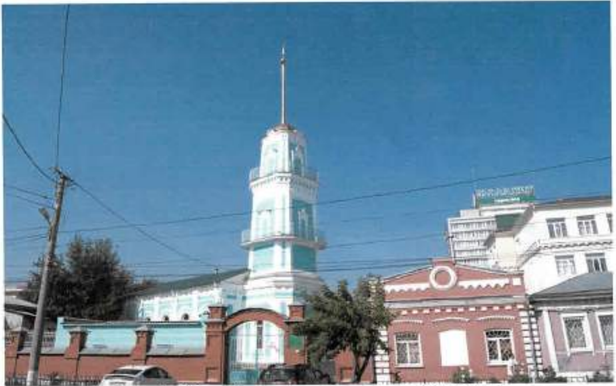
Фото 1. Общий вид с северо-восточной стороны
