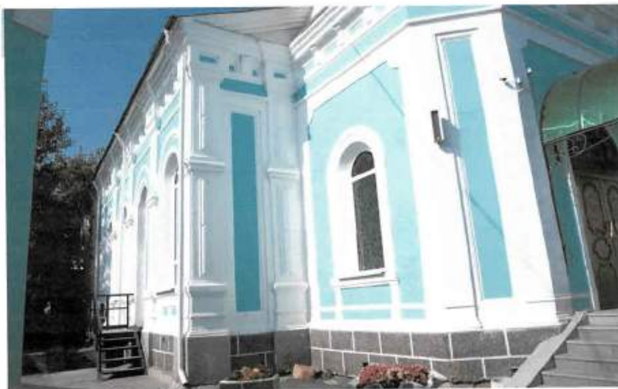
Фото 6. Вид на здание с северо-восточной стороны
