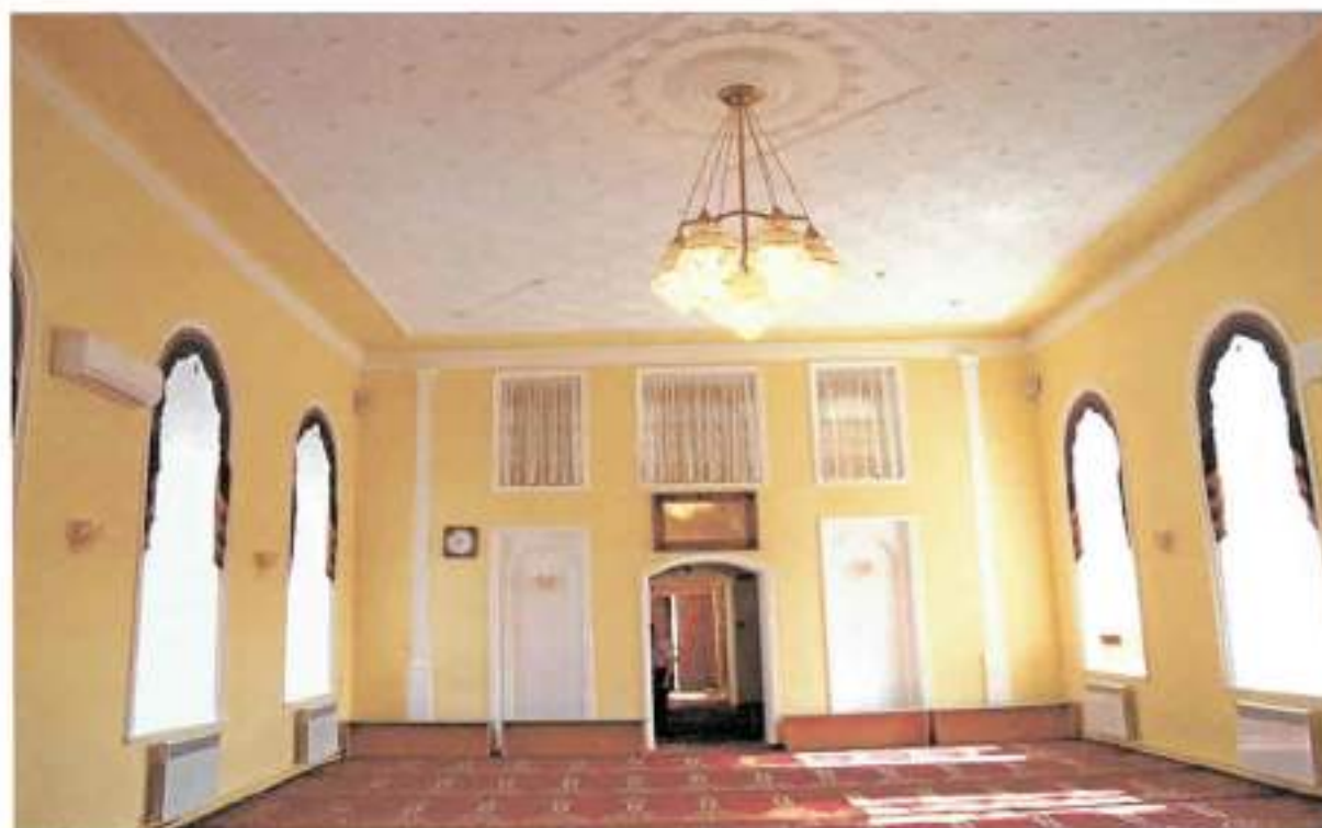
Фото 16. Фрагмент интерьера помещения № 4 (по техпаспорту БТИ)
