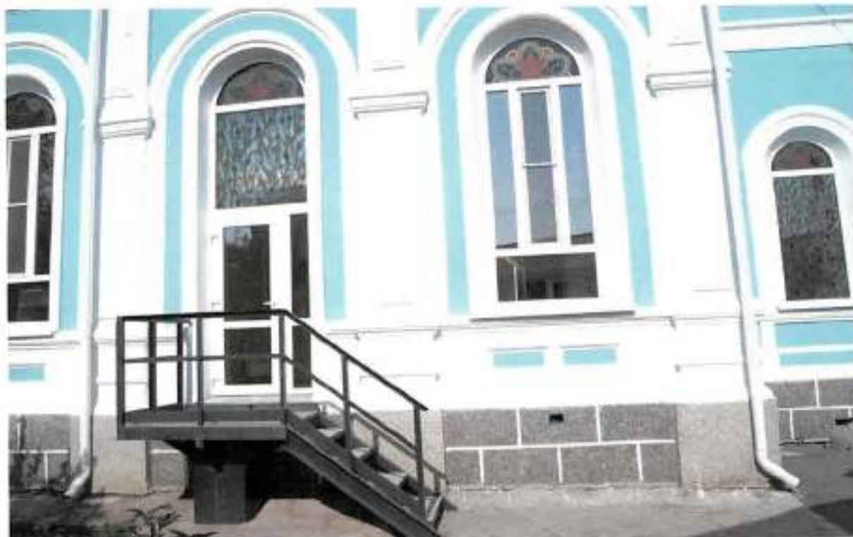
Фото 7. Фрагмент юго-восточного фасада. Вход в здание, выполненный из оконного проема
