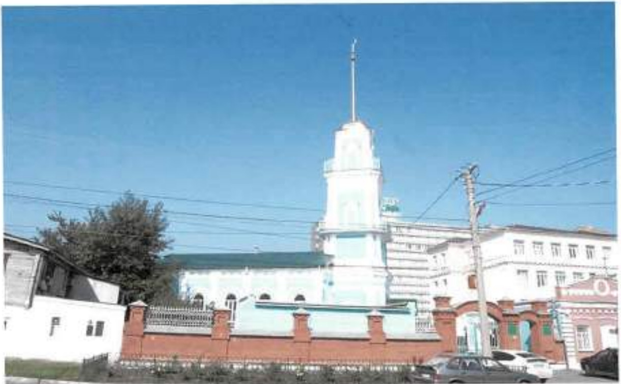
Фото 2. Вид на юго-восточный фасад здания мечети
