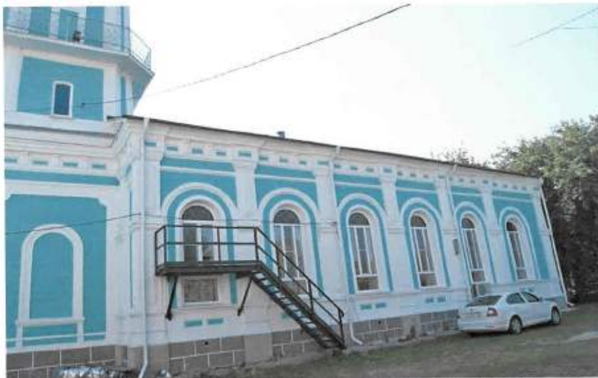
Фото 3. Фрагмент северо-западного фасада здания мечети
