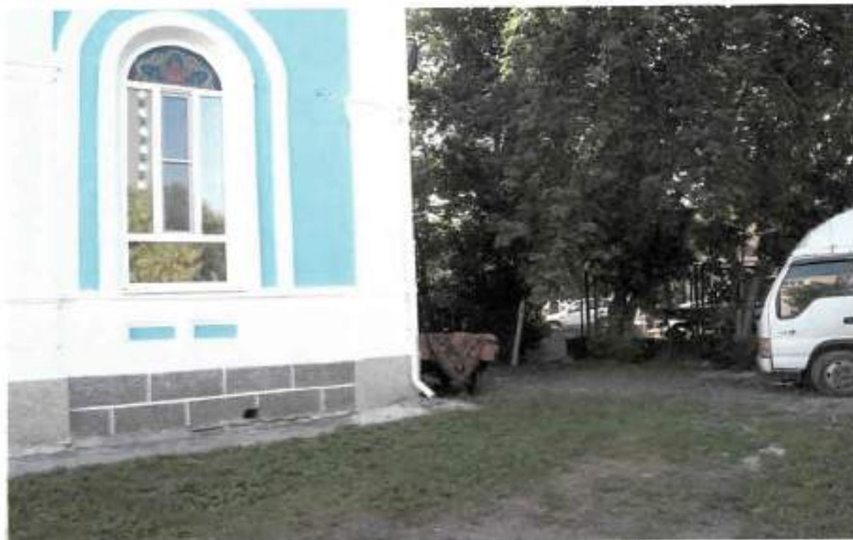
Фото 5. Фрагмент северо-западного фасада.
