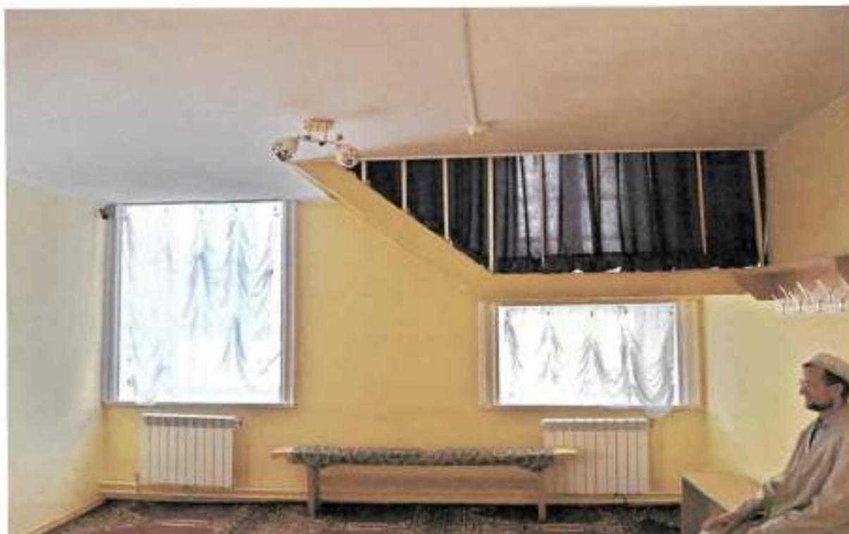
Фото 13. Фрагмент интерьера помещения № 2 (по техпаспорту БТИ)
