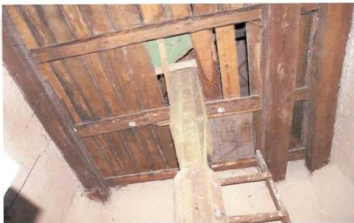
Фото 28. Вид на металлическую конструкцию, поддерживающую шпиль на куполе минарета
