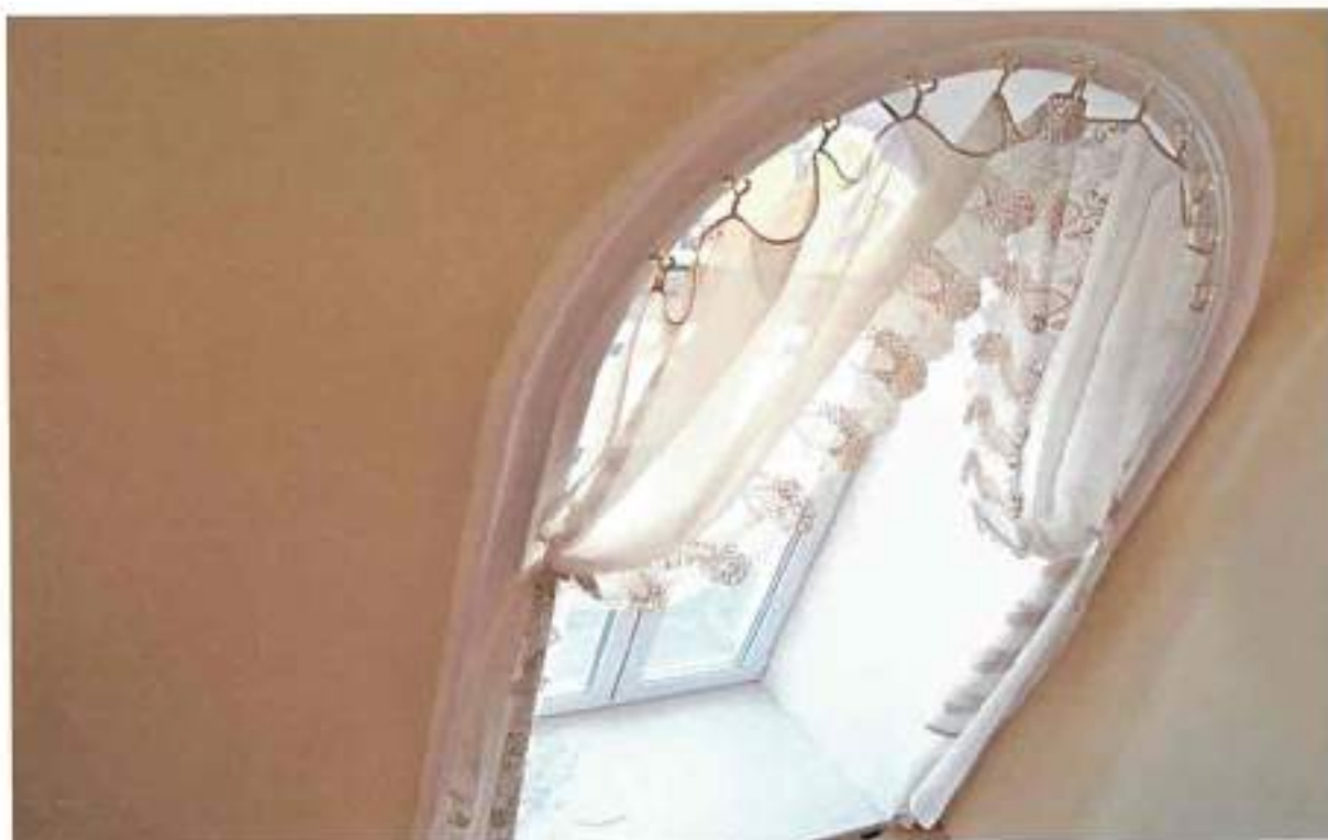
Фото 23. Вид на запасной выход из помещения № 3 (по техпаспорту БТИ), выполненный из оконного проема
