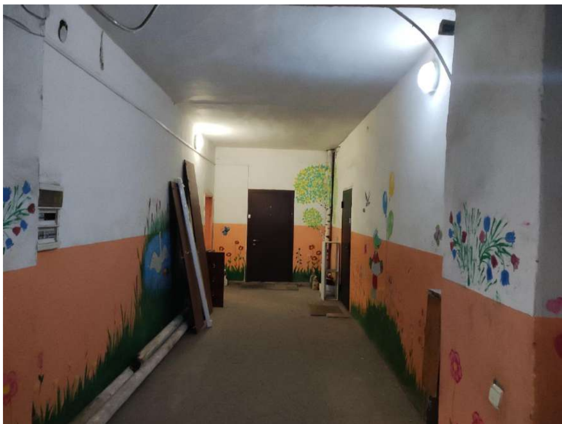
Приложение № 12. Усадебный комплекс Яушевых. г. Троицк, Октябрьская ул., 89,89а. Коридор. Фото по состоянию на ноябрь 2022 года.
