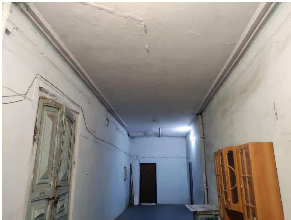
Приложение № 14. Усадебный комплекс Яушевых. г. Троицк, Октябрьская ул., 89,89а. Коридор. Фото по состоянию на ноябрь 2022 года.
