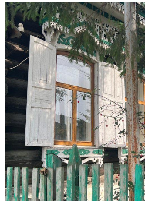
Оформление оконного проема западного фасада
