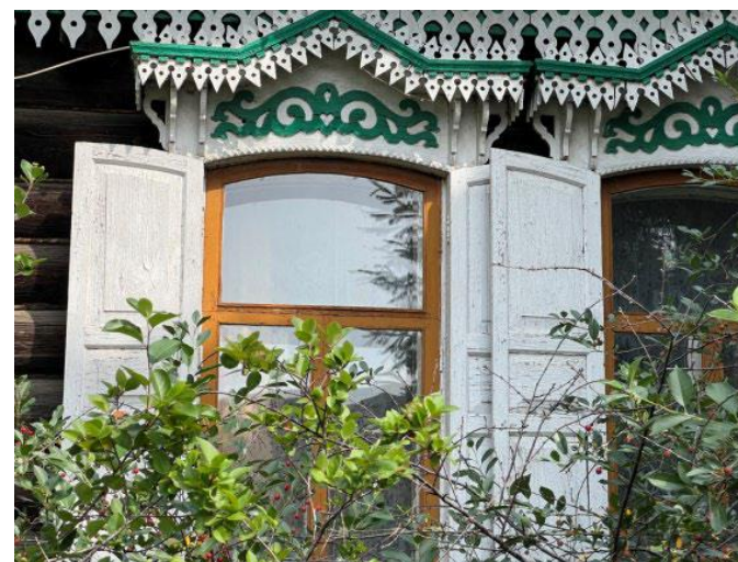
Сандрик оконных проемов
