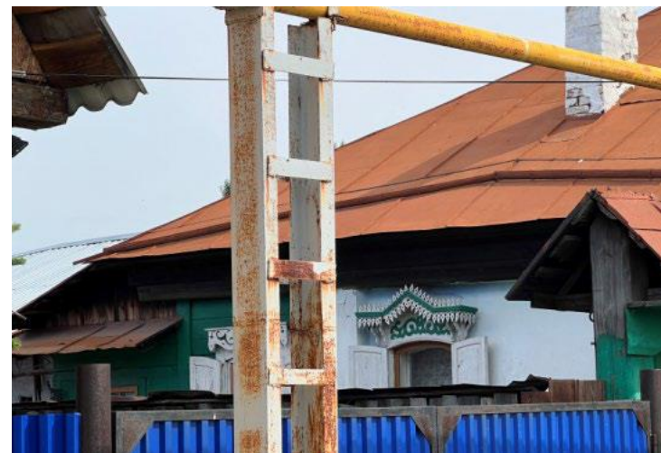
Северный фасад. Фрагмент
