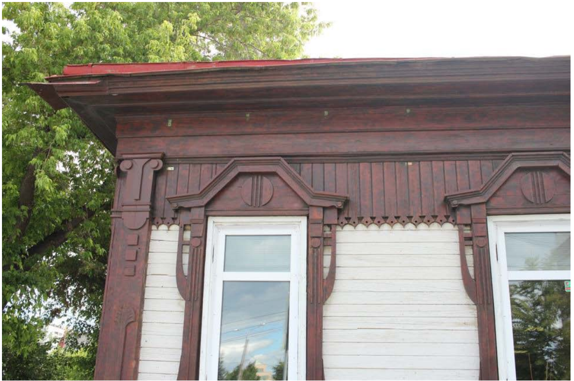
Северный фасад. Фрагмент. Карниз. Капитель пилястры. Резная обшивка стен.
