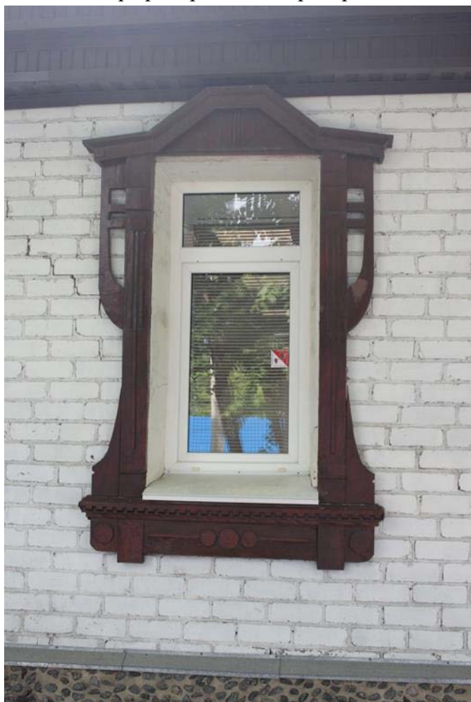
Северный фасад. Наличник пристроя.
