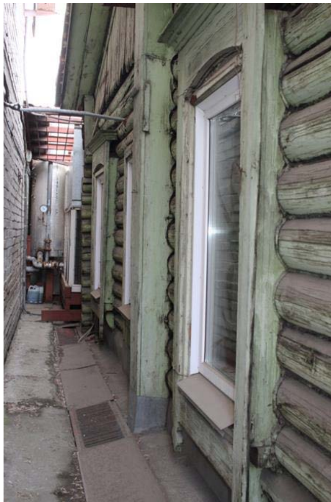
Вид на западный фасад
