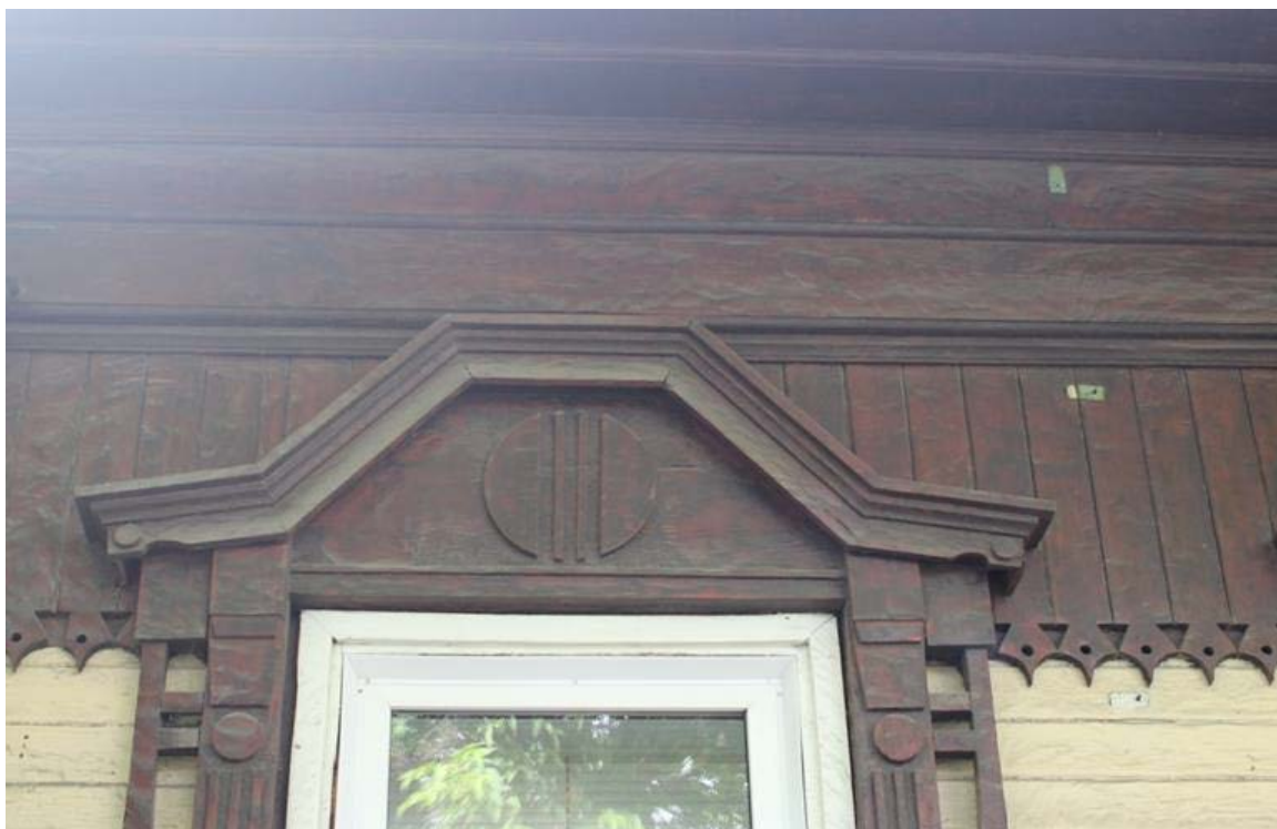
Фрагмент восточного фасада. Очелье наличника. Профилированный архитрав.
