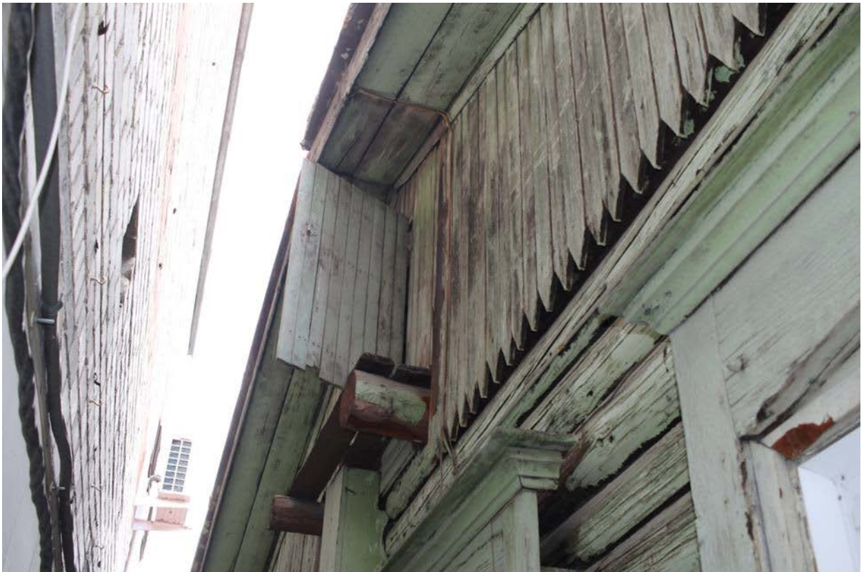
Фрагмент западного фасада. Лаз на чердак.
