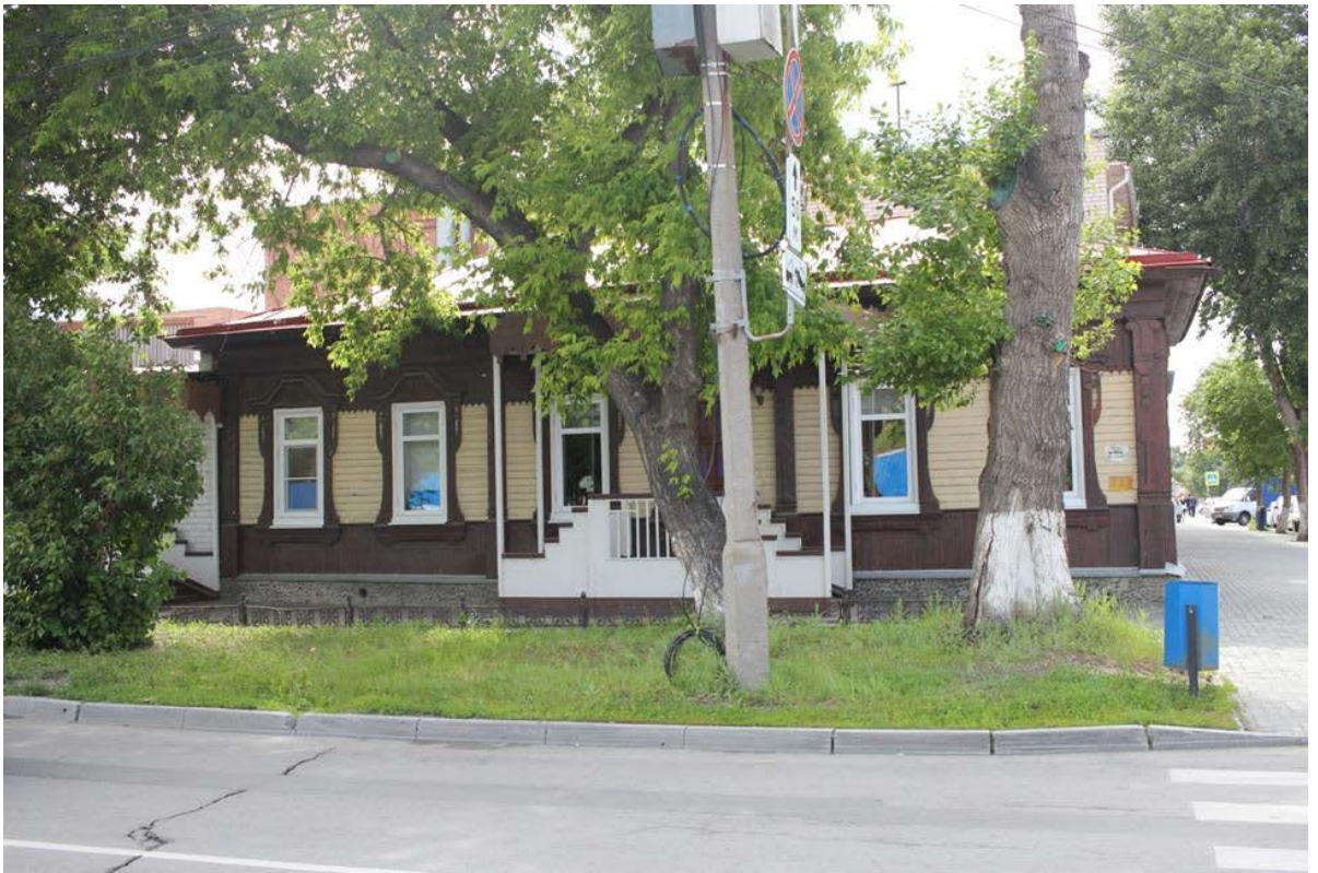
Восточный фасад здания
