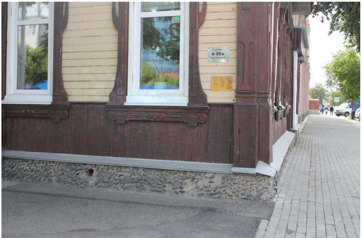
Цоколь восточного фасада. Угловые пилястры, закрывающие перерубы.
