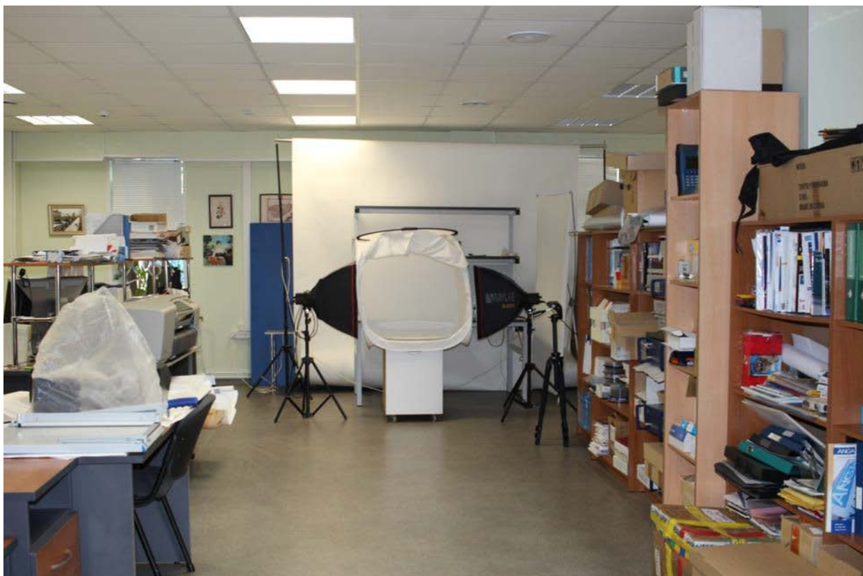
Современный интерьер с подвесными потолками типа "Армстронг" и линолеумом на полу
