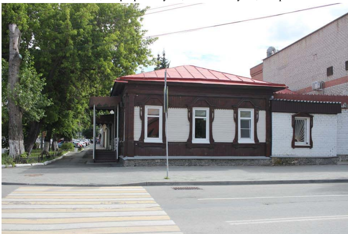
Северный фасад здания.
