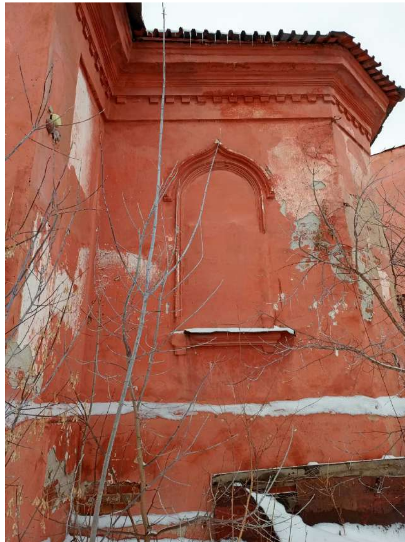
Рис. 10. Общий вид. Боковой (юго-восточный) фасад объема входа
