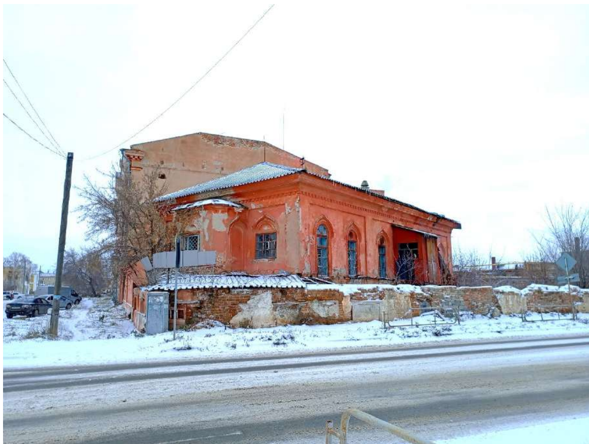
Рис. 3. Общий вид. Юго-восточный (боковой) и юго-западный фасады, михраб, ограда
