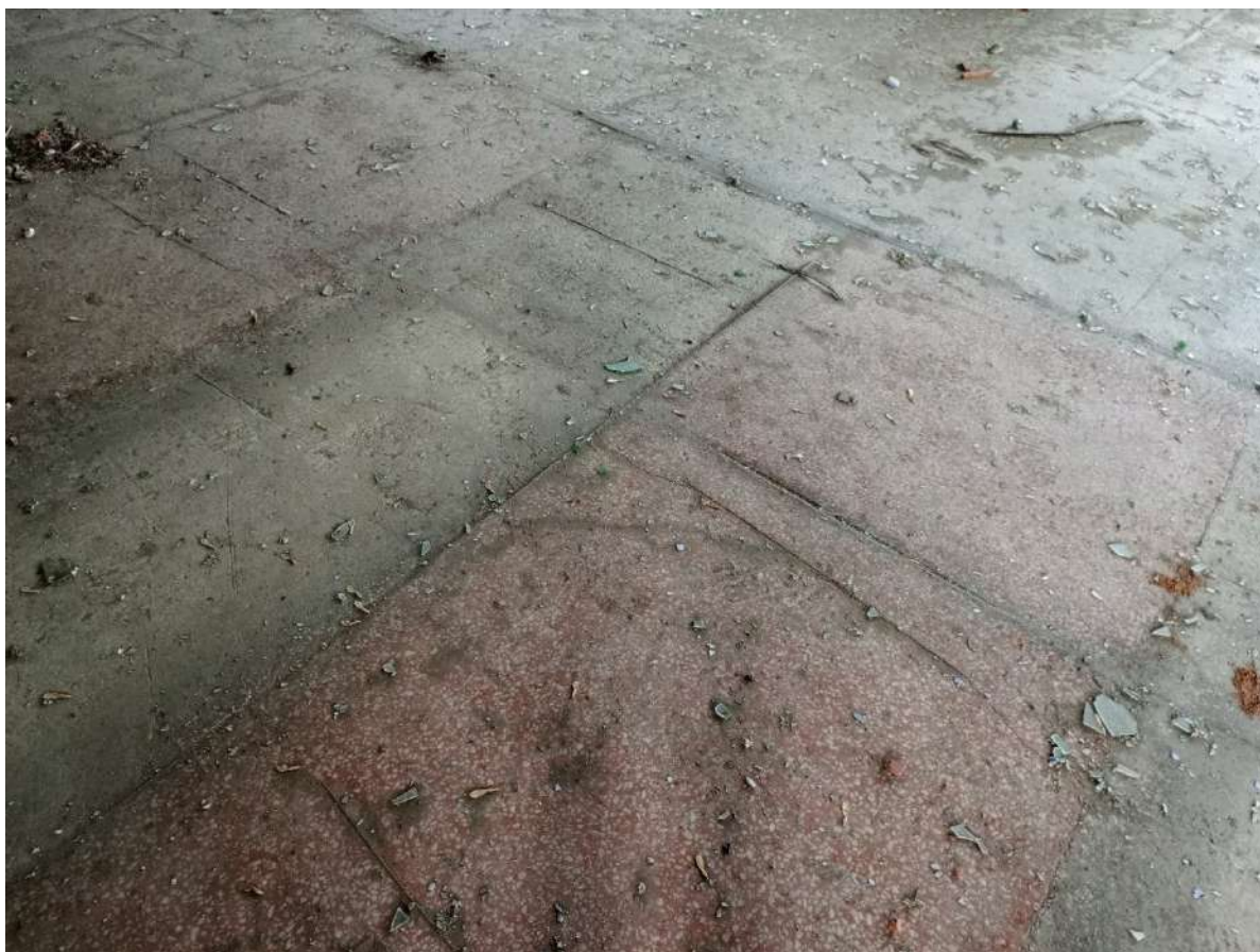
Рис. 52. Второй этаж бывшей молитвенной залы. Фрагмент межэтажного перекрытия
