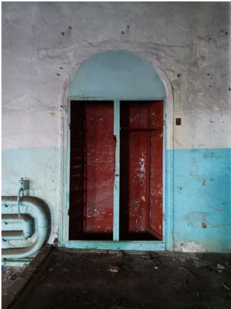
Рис. 47. Второй этаж бывшей молитвенной залы. Ниша заложеного окна северо-западной стены
