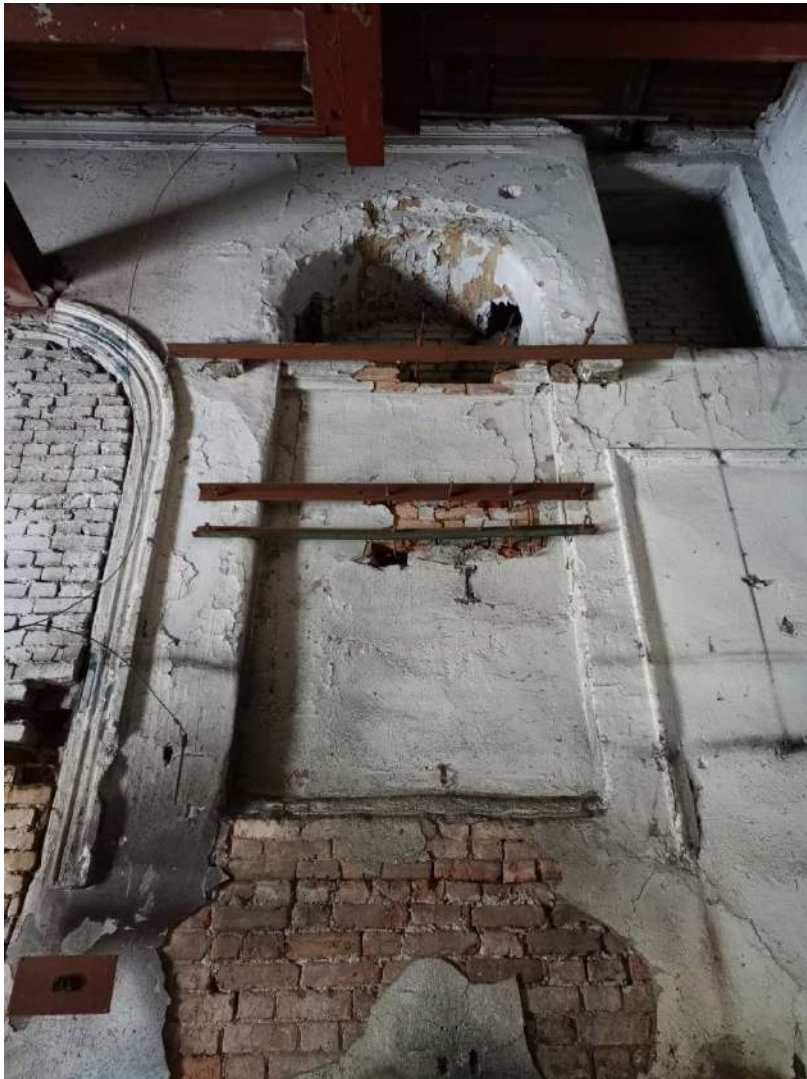
Рис. 29. Фрагмент внутренней стены между бывшим помещением служб и молитвенной залой. Северное заложенное окно
