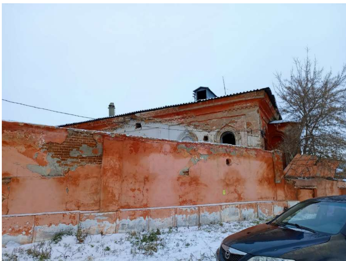
Рис. 6. Общий вид. Северо-западный (боковой) и юго-западный фасады, михраб, ограда территории ТЭМЗ
