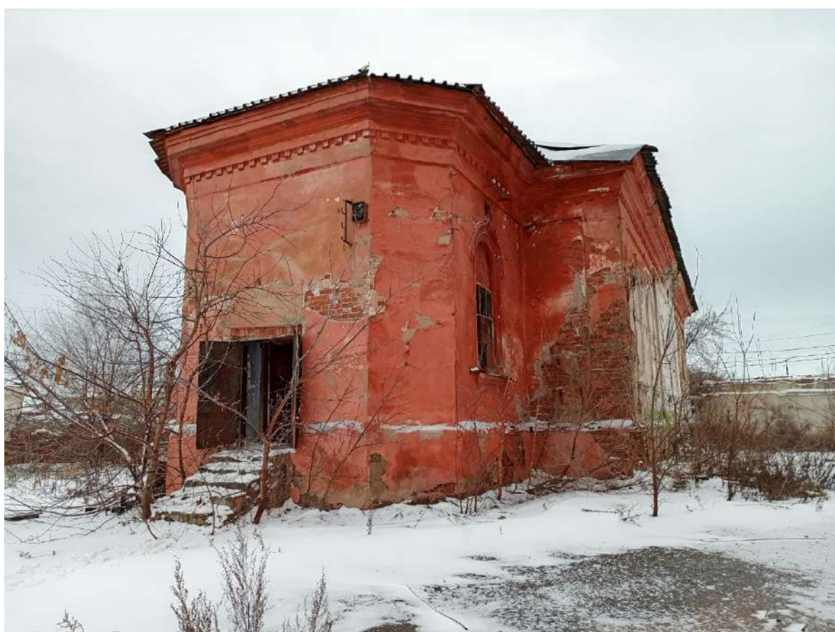
Рис. 8. Общий вид. Северо-западный (боковой), северо-восточный фасады, объема входа
