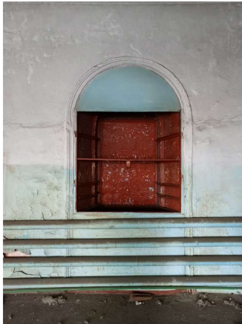
Рис. 48. Второй этаж бывшей молитвенной залы. Ниша заложеного окна северо-западной стены
