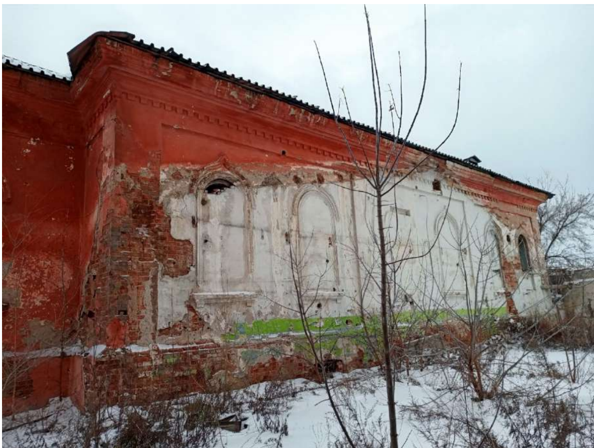
Рис. 7. Общий вид. Северо-западный (боковой) фасад
