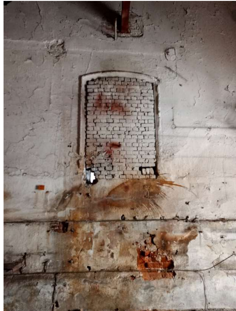
Рис. 28. Фрагмент внутренней стены между бывшим помещением служб и омовений и объемом входа. Заложный входной проем
