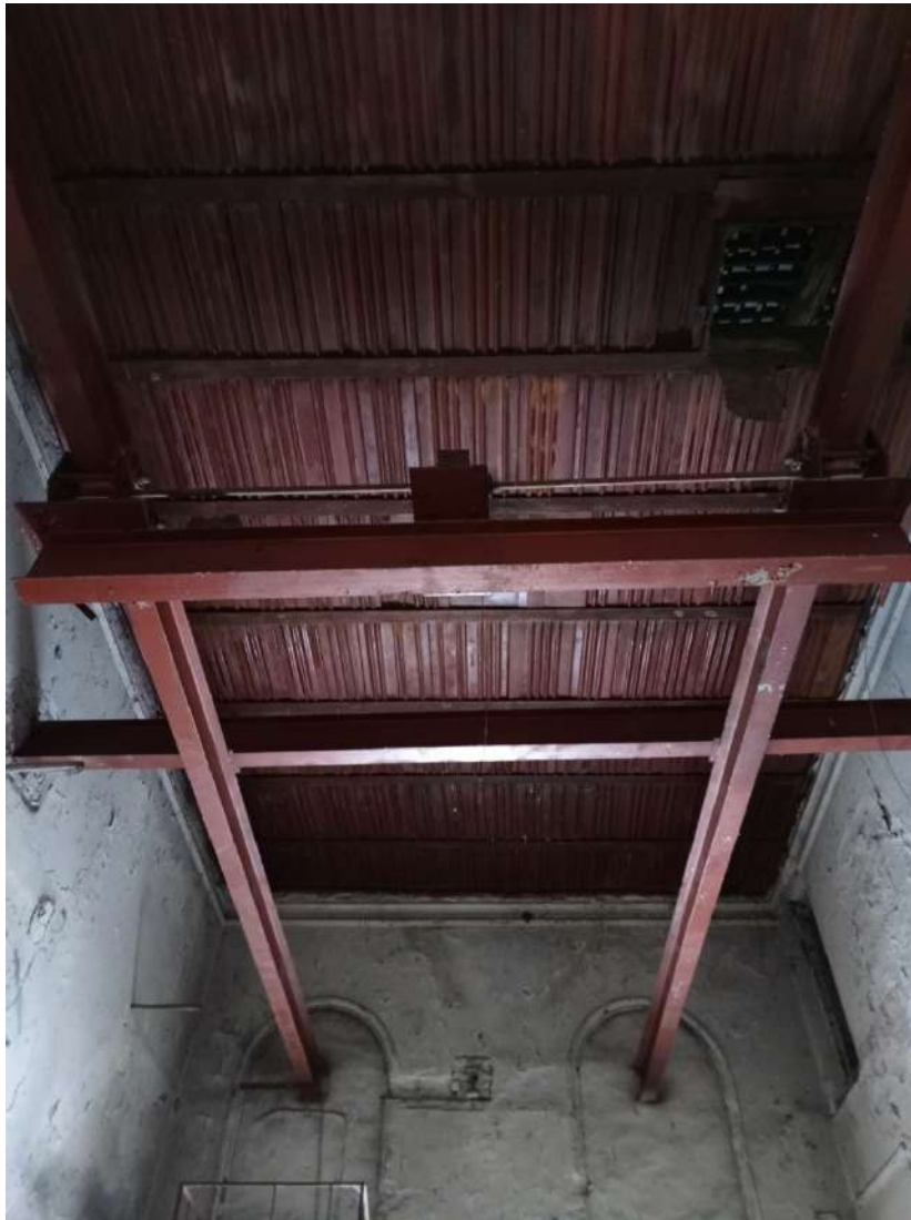
Рис. 25. Бывшее помещение служб и омовений. Фрагмент кровли
