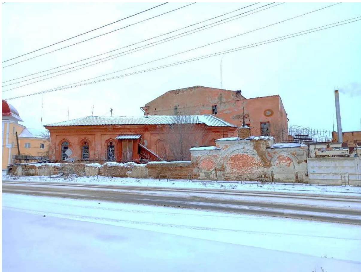
Рис. 1. Общий вид. Боковой (юго-восточный) фасад, ограда с воротами
