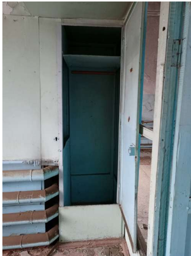
Рис. 57. Второй этаж. Шкаф конструкции перегородки михраба
