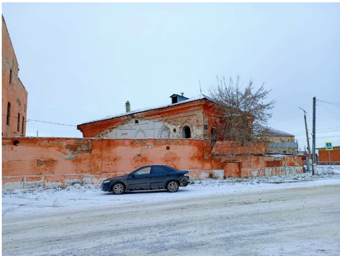
Рис. 5. Общий вид. Северо-западный (боковой) и юго-западный фасады, михраб, ограда территории ТЭМЗ
