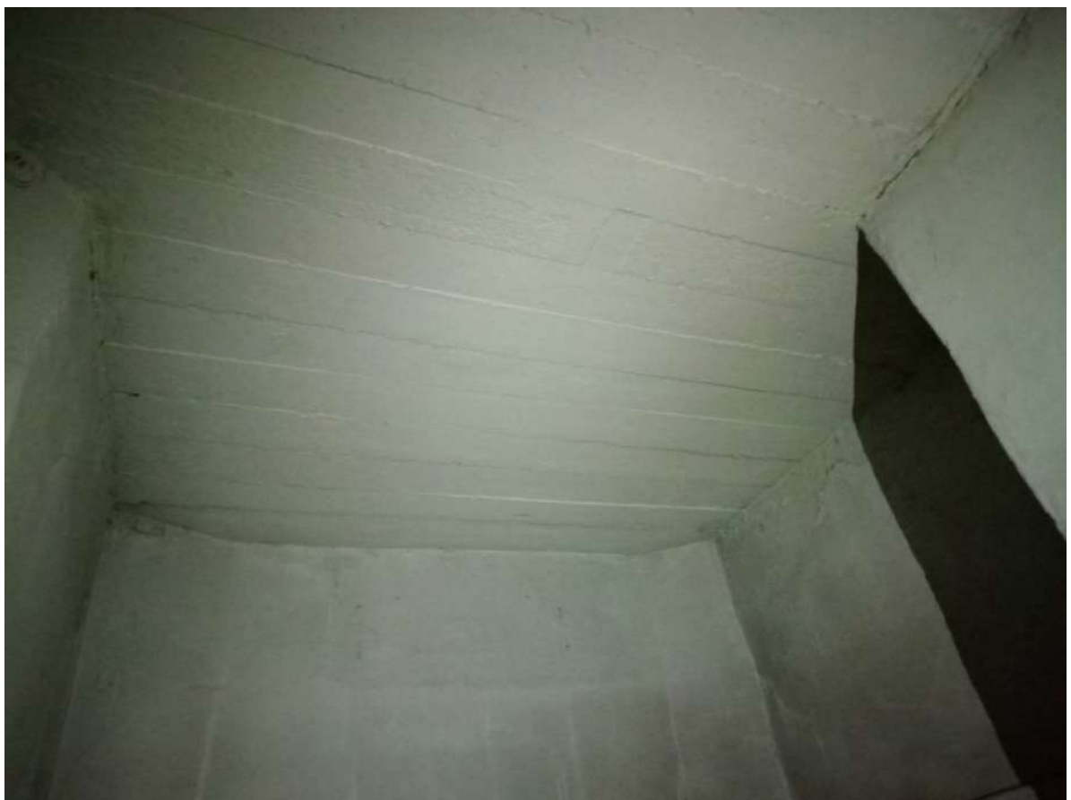
Рис. 38. Первый этаж бывшей молитвенной залы. Межэтажное перекрытие
