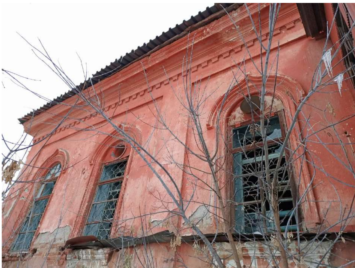
Рис. 16. Фрагмент бокового (юго-восточного) фасада
