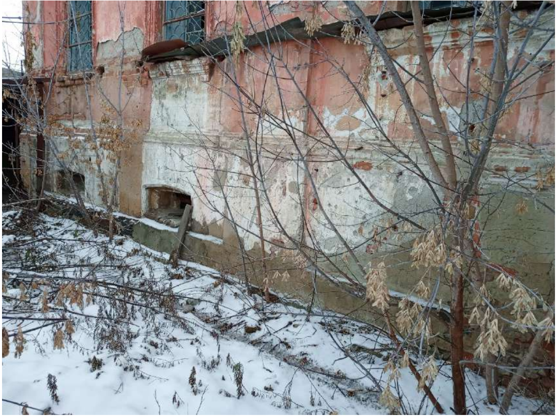
Рис. 17. Фрагмент бокового (юго-восточного) фасада
