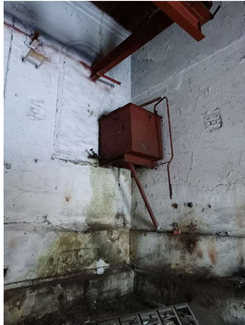
Рис. 30. Помещение служб и омовений. Северо-восточный угол
