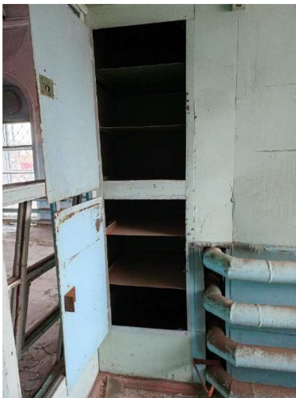
Рис. 58. Второй этаж. Шкаф конструкции перегородки михраба
