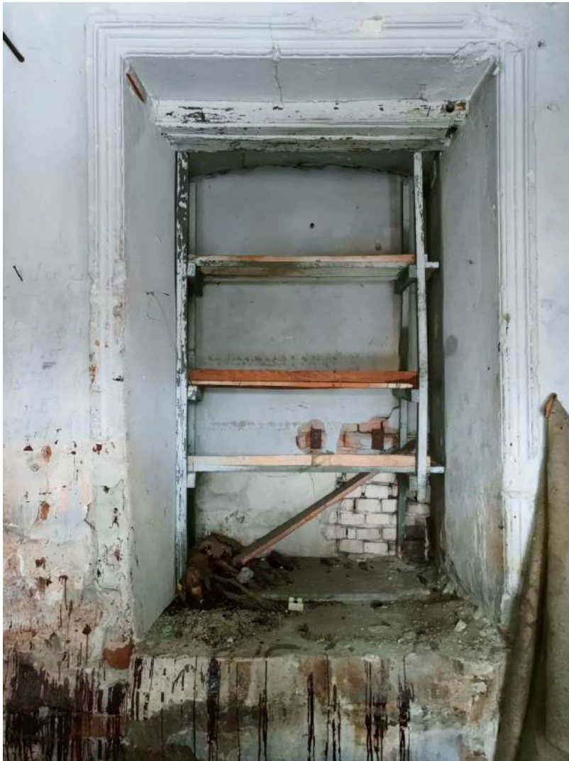
Рис. 21. Объем входа. Заложена входной проем в бывшее помещене служб и омовений
