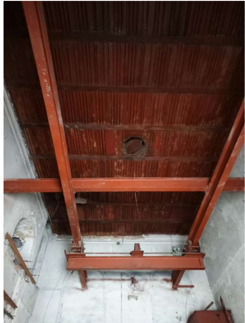
Рис. 26. Бывшее помещение служб и омовений. Фрагмент кровли
